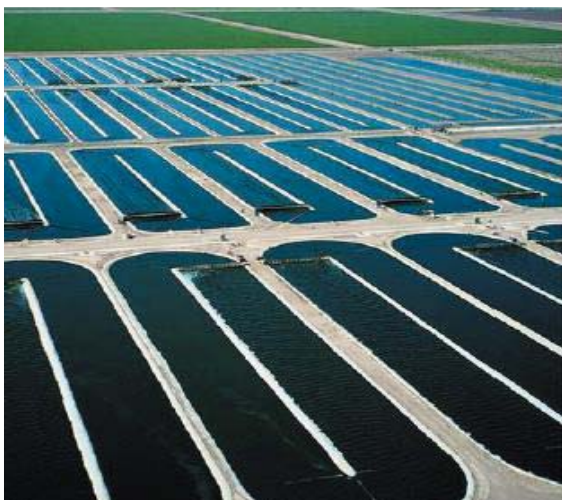
Figura 7 - Raceway ponds com o cultivo de microalgas.
