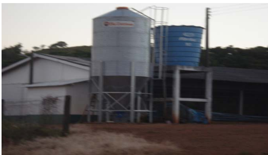
Foto 20 – Infra-estrutura da propriedade - Barracão automatizado para criação de frango.
