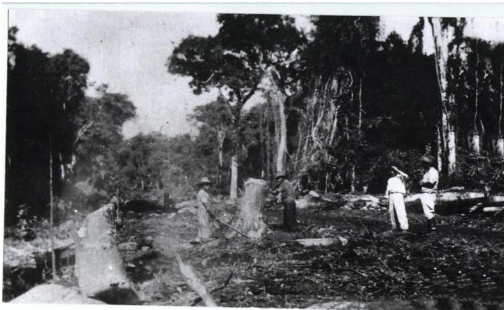
Foto 5 – Derrubada da mata para construção de estradas – 1937. Fonte: Acervo fotográfico Jorge Takano.
