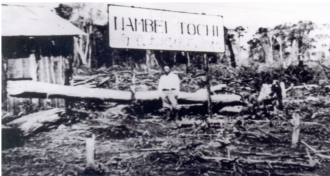
Foto 2 – Construção do Escritório da Nambei Tochi. Início da construção do Escritório da Nambei Tochi. Placa indicando o local do futuro Escritório da Nambei Tochi Kabushiki Kaisha, concretizado em 1940. Escritório para vendas de lotes rurais e urbanos (datas). Nesse escritório também eram expedidos documentos de licença para construção das casas, plantas (memorial), feito por Issami Tokano, que foi engenheiro agrimensor. KIYOSHI TAKANO – 1936/37.
