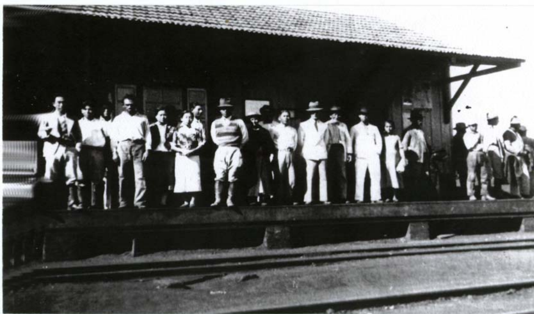
Foto 1 – Inauguração da Estação Férrea em 20 de agosto de 1936. As pessoas esperam a primeira Maria Fumaça que chegava a Uraí. Foi uma festa a chegada. O rápido desenvolvimento da cidade foi em parte devido à estrada de ferro que na época ligava Ourinhos à Jataizinho.
