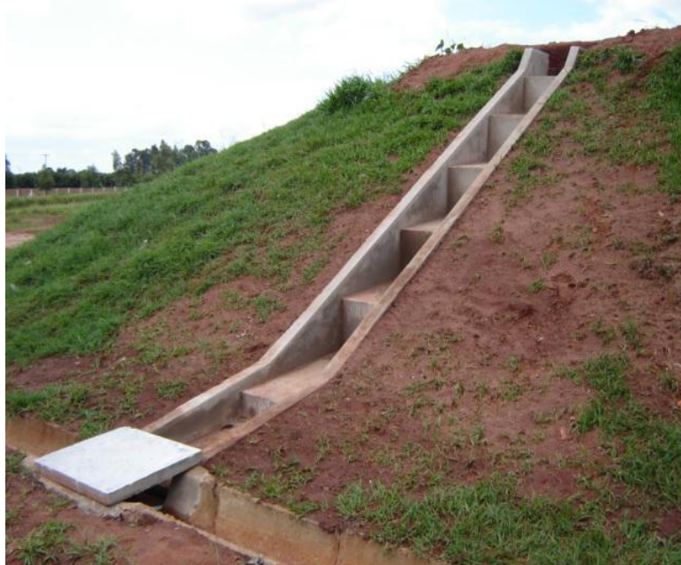
Figura 4 – Escada de dissipação de energia para águas pluviais da célula 1 do aterro de Cianorte-PR
