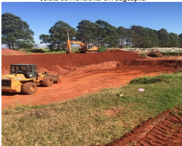
Figura 5.7 - Construção do novo aterro em vala para recebimento de resíduos da coleta convencional em Jaguapitã
