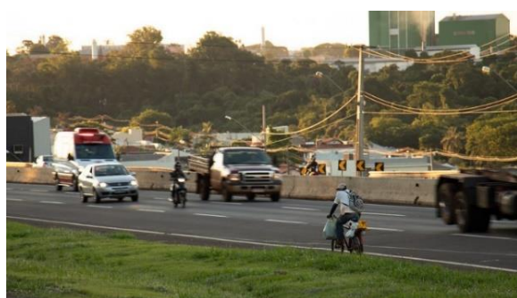
Figura 2.12 – Trecho da rodovia PR-445 em Londrina/PR
