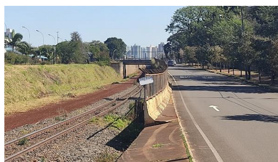
Figura 2.13 - Infraestrutura ferroviária em Maringá/PR
