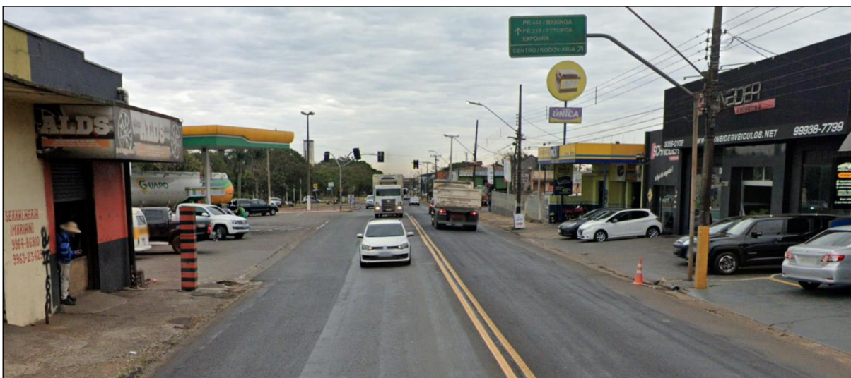
Figura 2.9 – Rodovia PR-369, trecho na área urbana de Arapongas/PR
