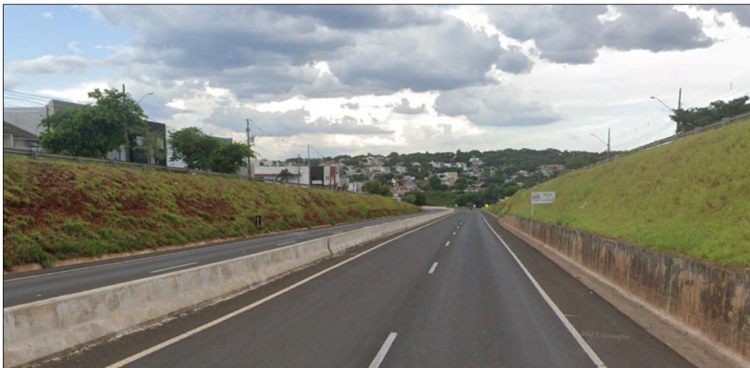
Figura 2.18 – Imagem do local mencionado anteriormente, destaque para a defesa de concreto e para o desnível da travessia urbana
