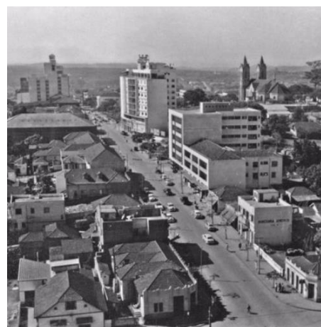
Figura 3.4 – Vista do centro de Londrina em 1951
