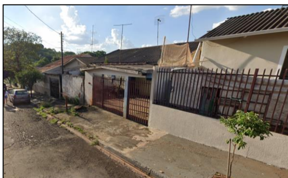
Figura 5.10 – Rua residencial com edificações de padrão popular
