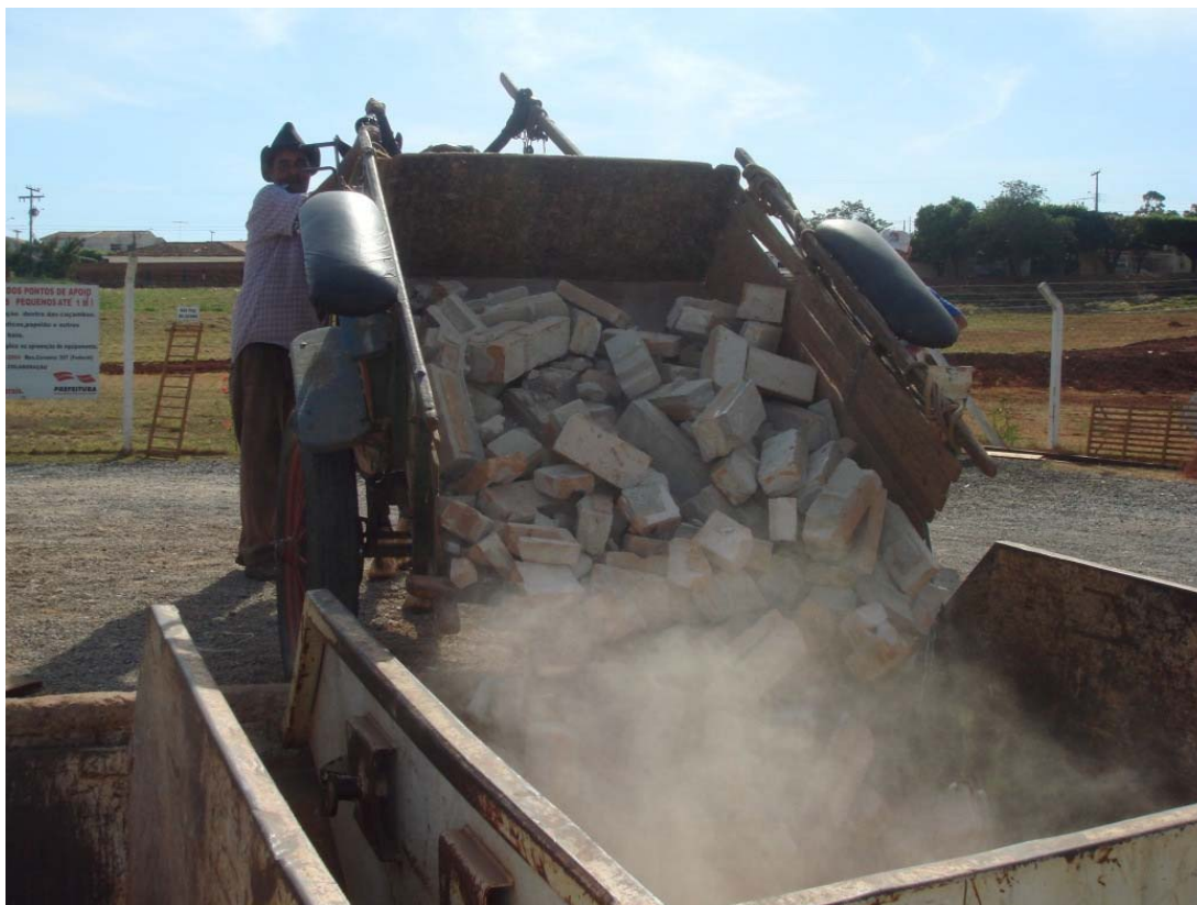
Figura 35 – Resíduos sendo descarregados na caçamba própria
