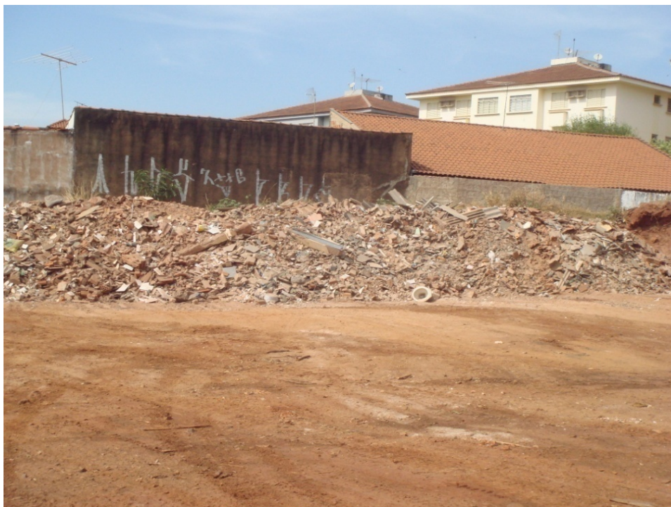
Figura 22 – RCC depositado em um Ponto de Apoio em Sistema com unidades abertas do Município de São José do Rio Preto - 2008
