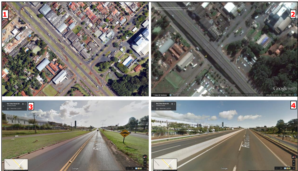
Figura 26 - Composição de imagens do cruzamento da Rod. PR 445 com Av. Arthur Thomas, antes e após as obras de duplicação da rodovia
