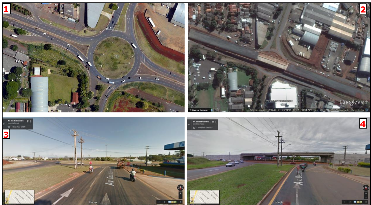
Figura 17 - Composição de imagens do cruzamento da Av. Dez de Dezembro com PR 445 e as alterações ocorridas após as obras de duplicação da rodovia
