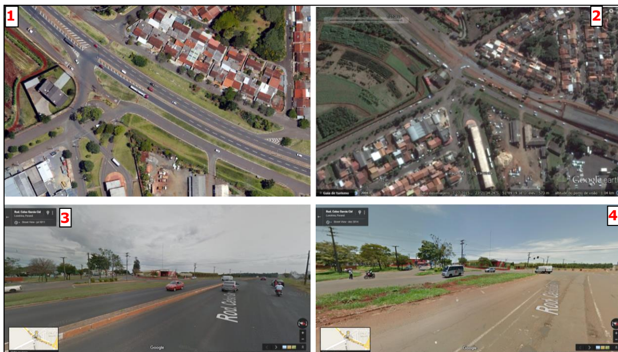
Figura 30 - Composição de imagens do cruzamento da rodovia PR 445 com Av. Cheply Tanus Daher
