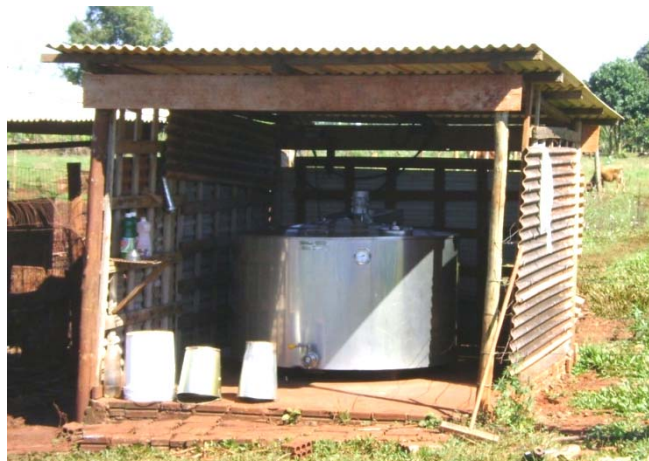
Imagem 9 – Tanque de expansão coletivo
