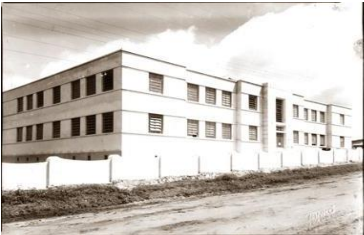
Fonte: Arquivo Colégio Estadual Rio Branco. Autor: José Nicolau Tanko.
