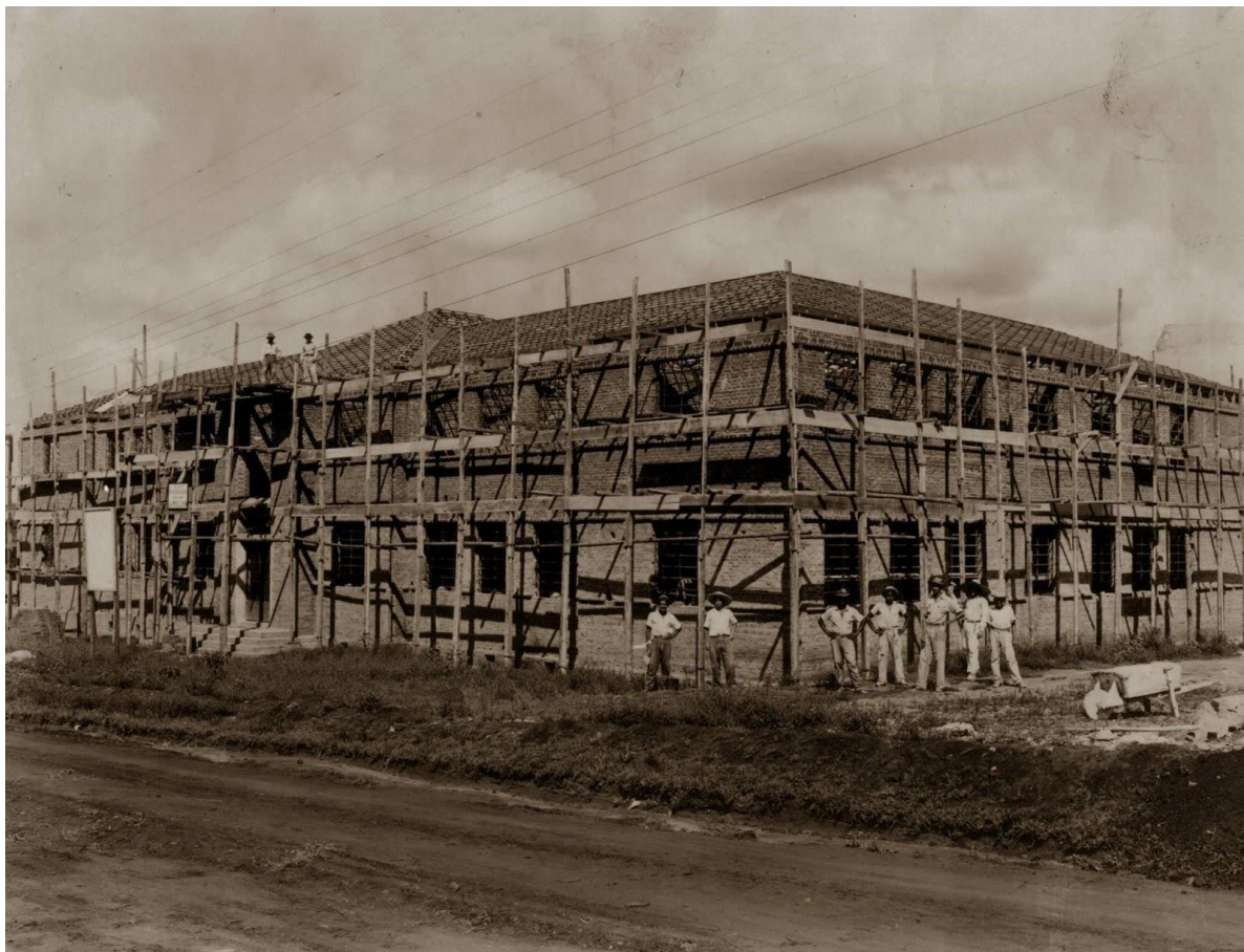
Ginásio Estadual em construção.
