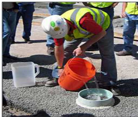
Figura 2.15 – Método ASTM C1701 para medição de permeabilidade em campo
