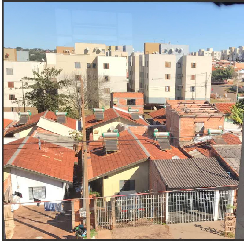
Figura 4 - Casa geminada no bairro Vista Bela
