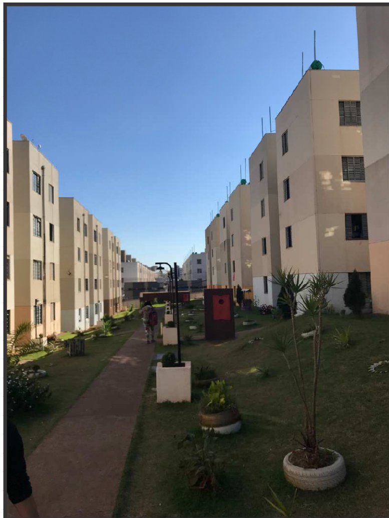
Figura 5 - Pátio dos Prédios da COHAB/LD
