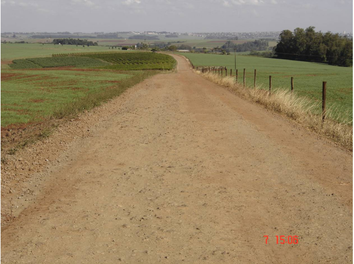
Foto: Estrada Velha Warta - Londrina readequada em 2002.
