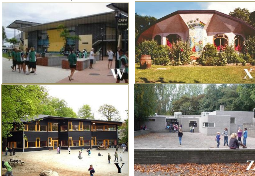
Figura 49 – Oitava sequência: “aparência/estética” de fachadas de edifícios escolares. W - Canning Vale Community College , Austrália; X - Rudolf Steiner School Kings Langley , Inglaterra; Y - Rudolf Steiner-Skolen , Dinamarca; Z - Delftse Montessorischool , Holanda.
