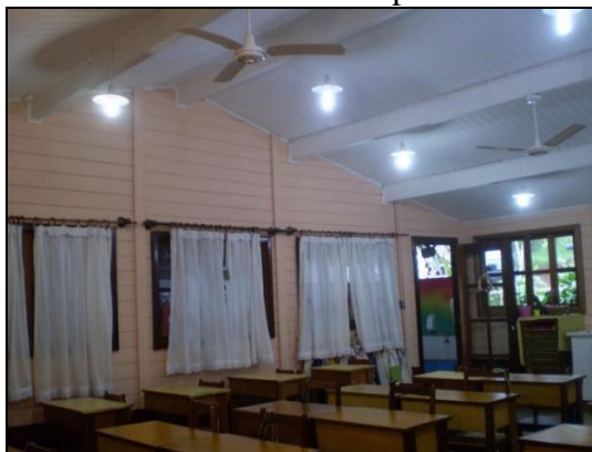
Figura 63 – Sala de aula ocupada pelo segundo ano: formato ortogonal da planta baixa e das janelas, com madeiramento do telhado aparente e forro inclinado.
