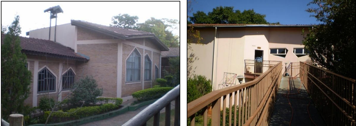
Figura 37 – Escola Waldorf no interior paulista objeto do estudo de caso – primeira (esquerda) e última (direita) ampliações, concebidas sob os parâmetros de projeto Waldorf.
