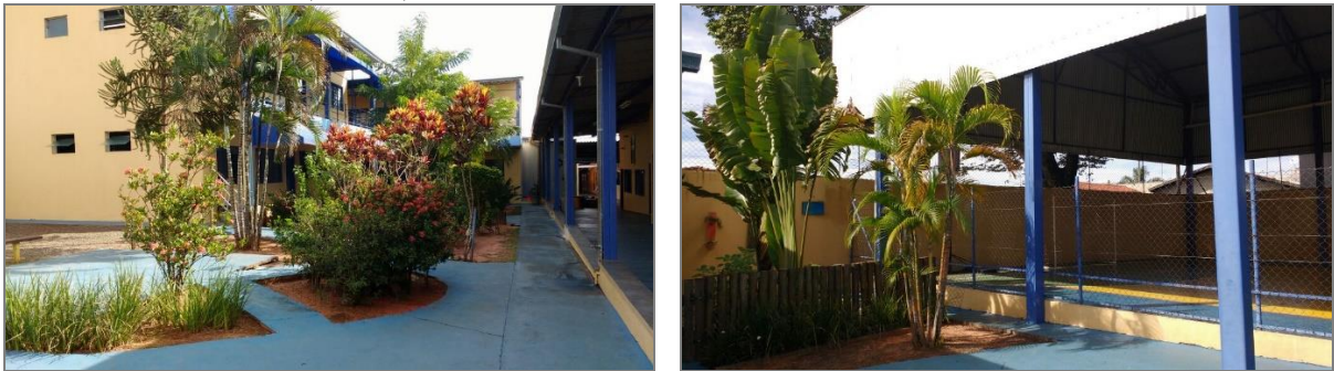
Figura 40 – Área externa ajardinada e edificação de dois pavimentos – setor do ensino fundamental II e médio na edificação (esquerda). Jardim e quadra poliesportiva coberta (direita).
