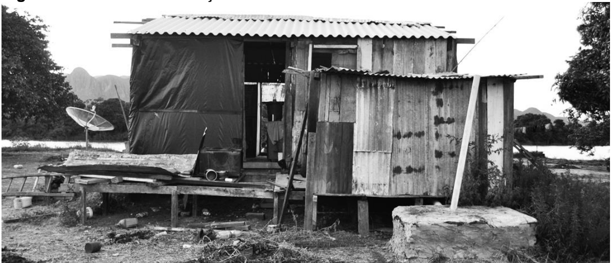
Figura 20: Moradia em situação de risco
