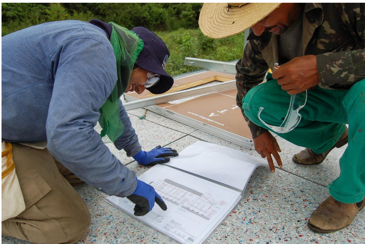
Figura 50: Leitura do projeto no local de montagem.
