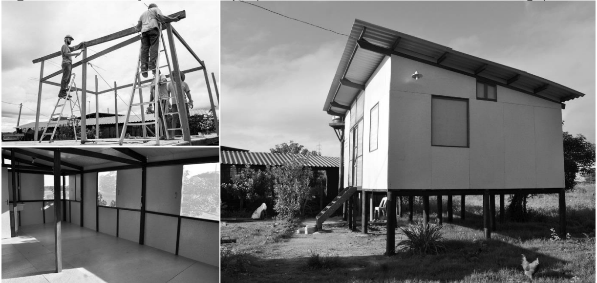
Figura 23: Construção do Protótipo (Cozinha comunitária em Porto da Manga).
