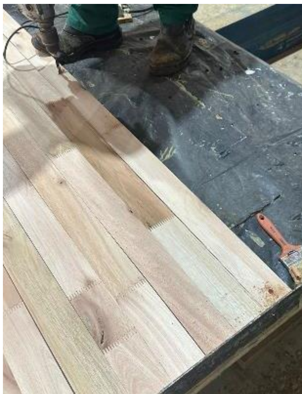
Figura 40 Aplicação de cavilhas para travamento do painel na prensagem. Fonte: Autor
