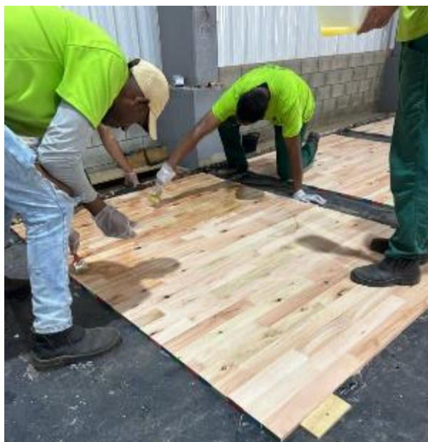
Figura 39 Aplicação do adesivo. Fonte: Autor
