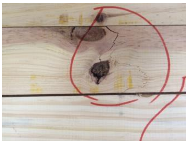
Figura 19 Painel MLCC detalhe da ruptura no nó. Fonte: ALENCAR (2015)
