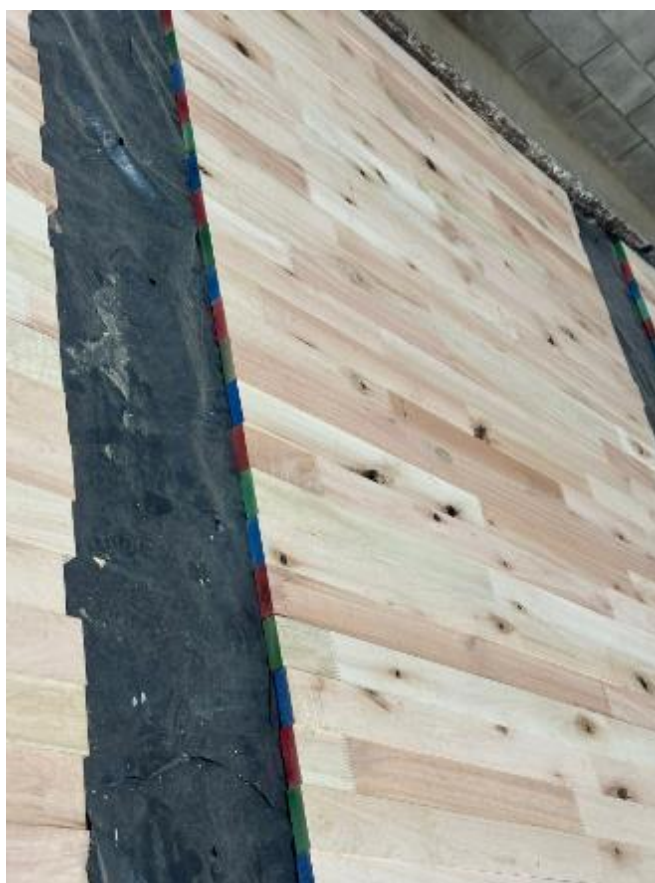
Figura 38 Montagem dos painéis MLCC mesclando os grupos de módulo de elasticidade das tábuas. Fonte: Autor
