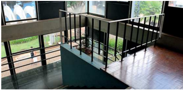
Figura 79: Escada principal – detalhes 2021
