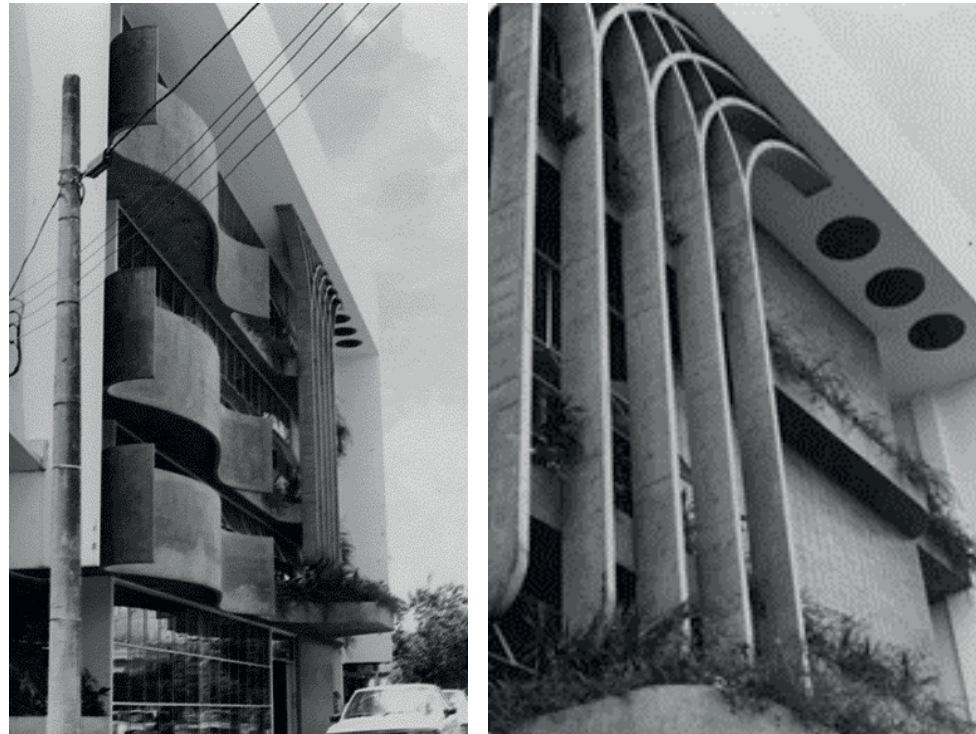
Figura 65: Edifício Comercial Trento Unipan 1983
