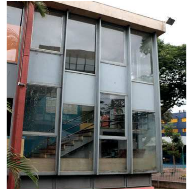
Figura 78: Escada interna pública vista da rua
