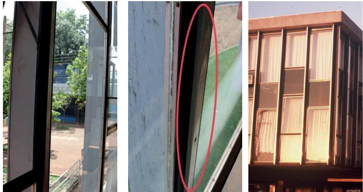
Figura 105: Acabamento em alumínio polido nos montantes metálicos
