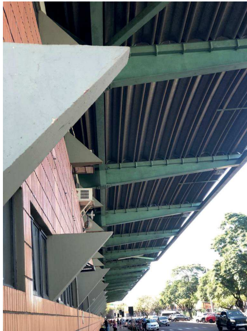
Figura 148: Fachada leste e detalhamento das peças em concreto
