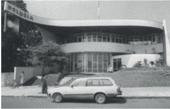
Figura 64: Edifício Rádio Colméia 1979
