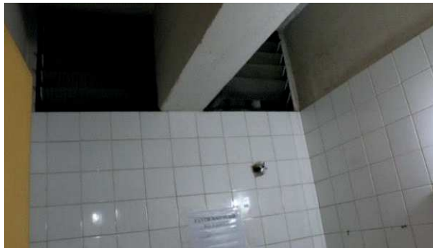
Figura 91: Detalhe das aberturas para os dutos
