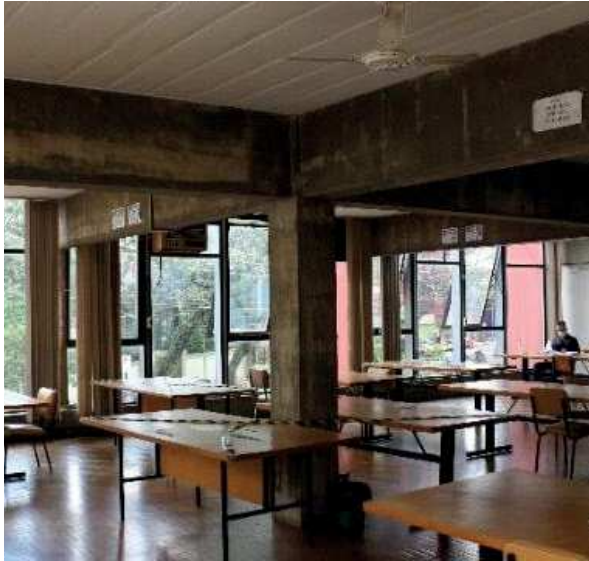
Figura 76: Vista parcial do 1º pavimento 2021
