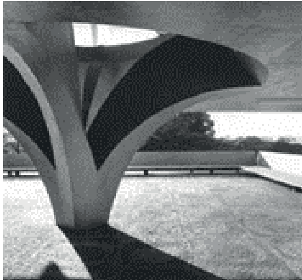
Figura 50: Detalhe do pilar na Rodoviária de Jaú – Artigas 1973
