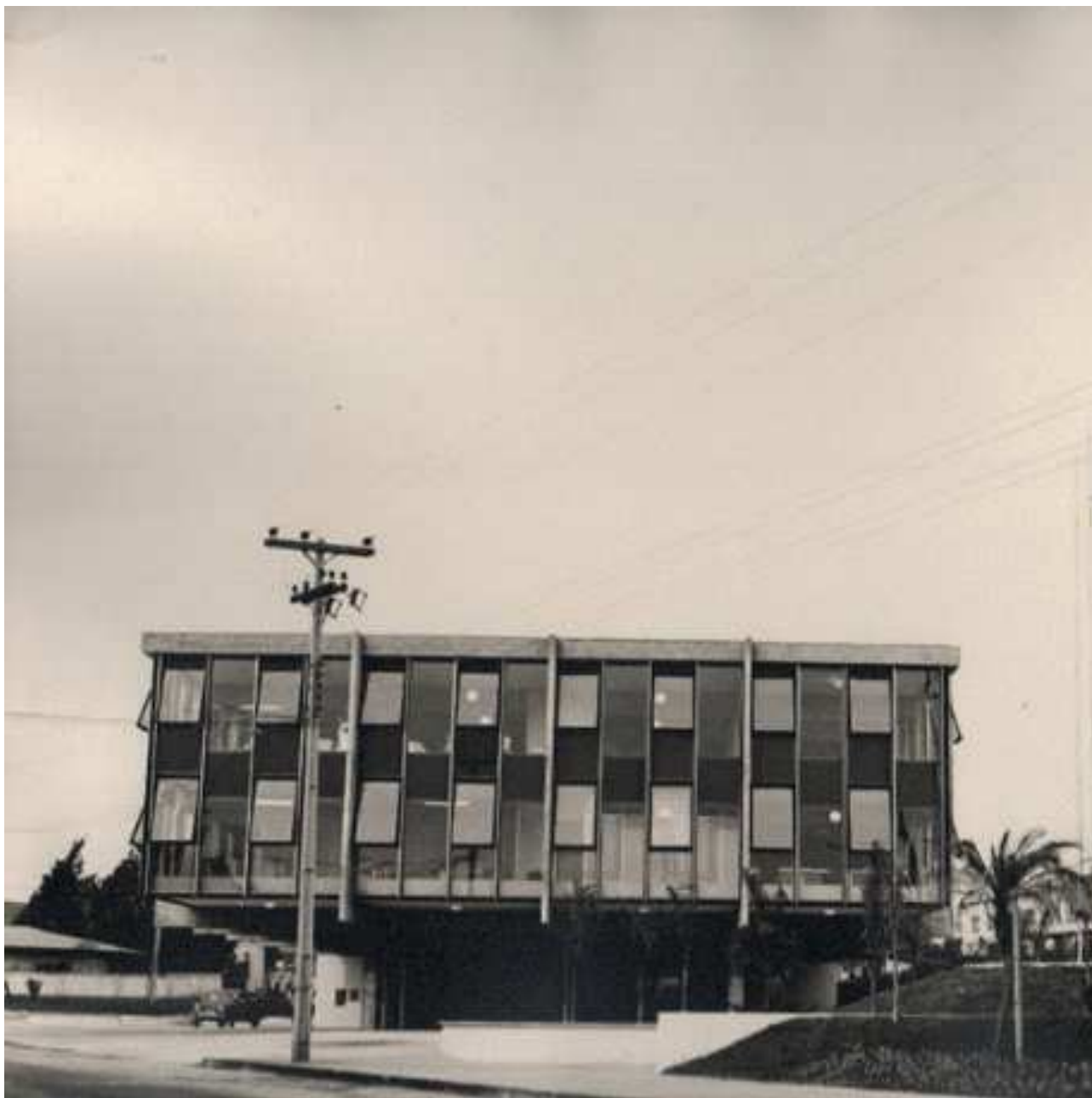
Figura 73: Foto do edifício na década de 1970 e simulação 3D com a fundação
