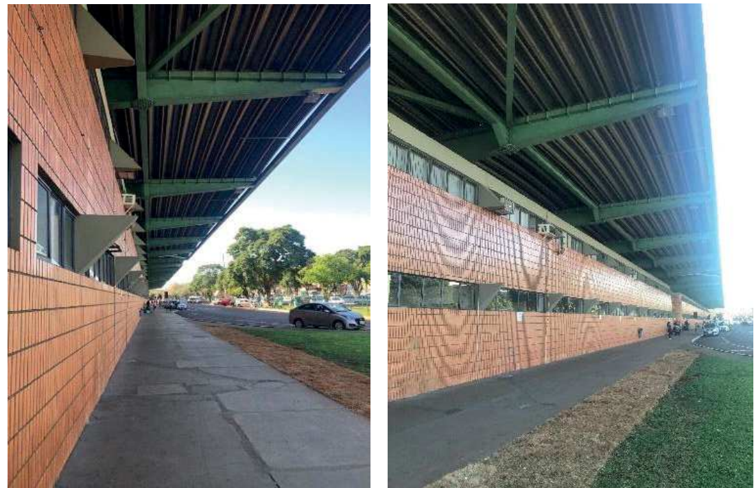
Figura 128: Fachada leste – janelas em fita interrompida
