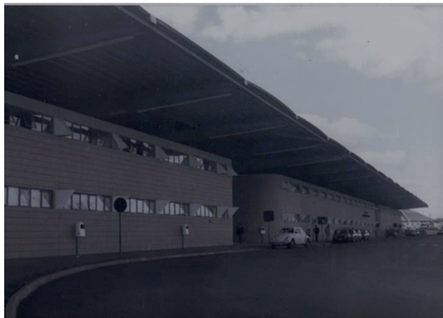
Figura 113: Foto do edifício
