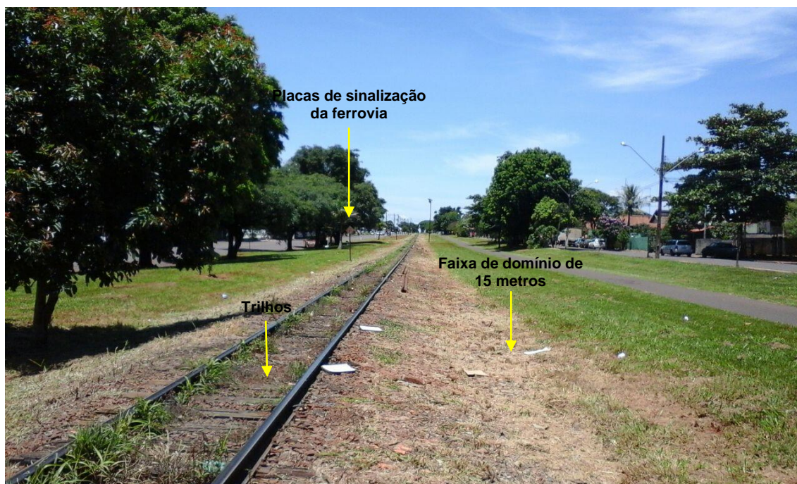
Figura 34 - Passagem da ferrovia na área urbana de Rolândia.
