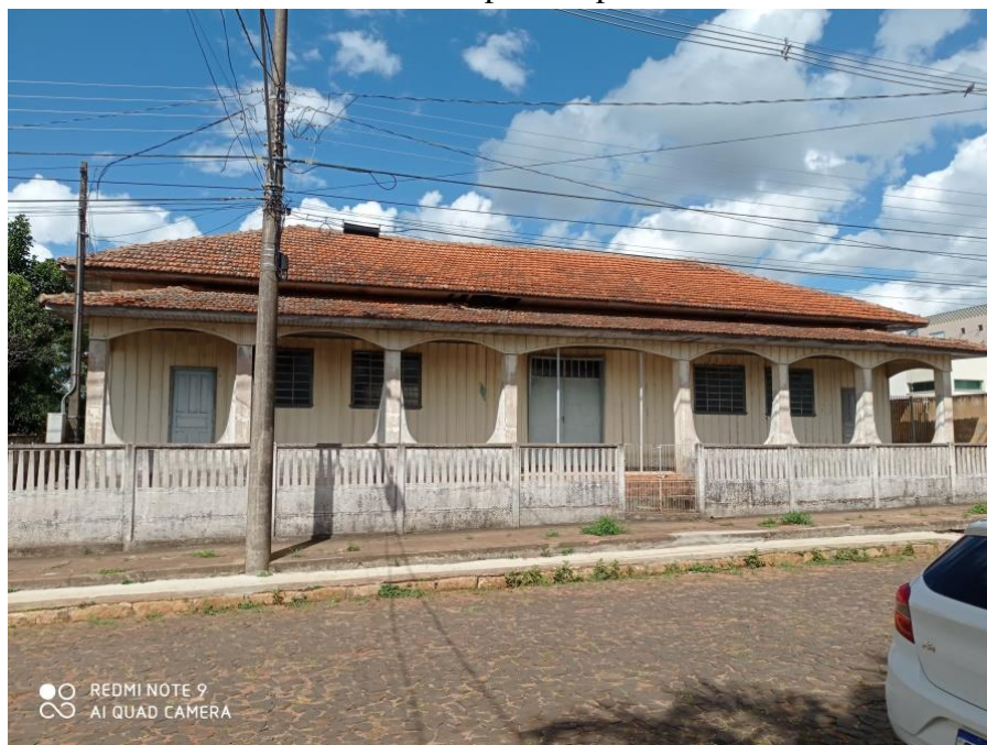
Figura 13 – Antiga fachada da Associação Japonesa de Ibaiti, hoje abandonada. Detalhe para a construção em madeira característica da imigração japonesa, embora as colunas escapem ao padrão.
