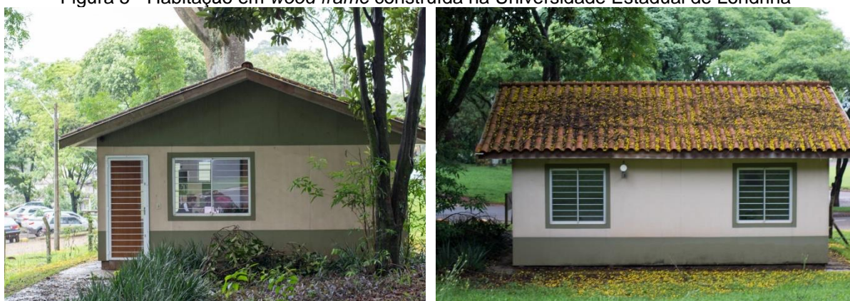
Figura 5 - Habitação em wood frame construída na Universidade Estadual de Londrina
