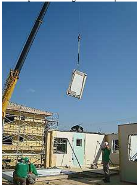
Figura 1 – Movimentação e montagem de um painel em wood frame
