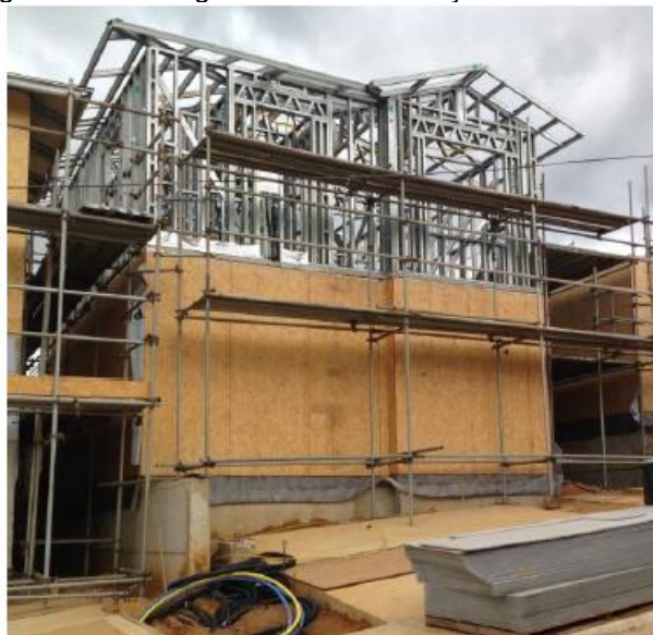
Figura 2 – Montagem de uma edificação em steel frame
