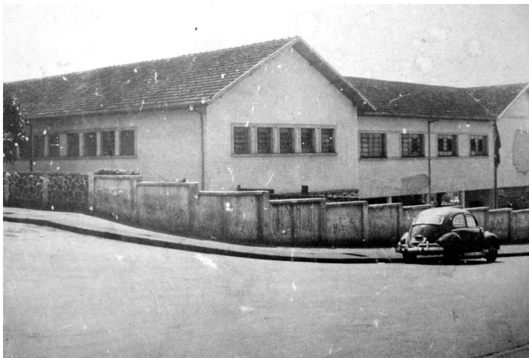
Foto 6 – Fachada lateral do IEEL em 1971.
