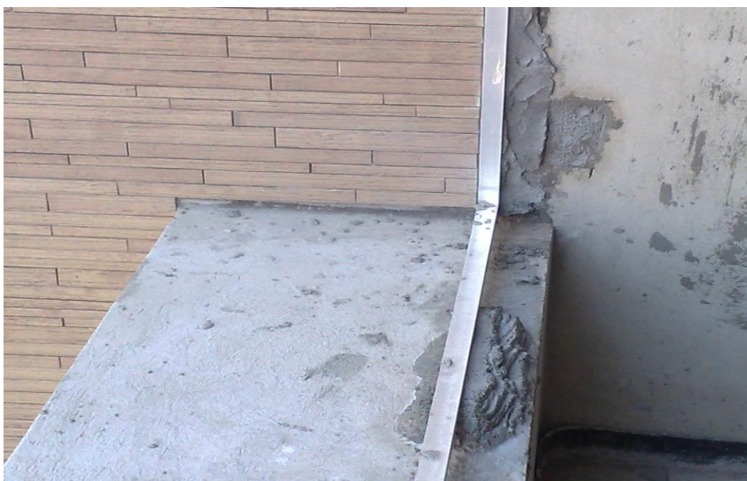
Figura 4 - Aplicação do contramarco na alvenaria
