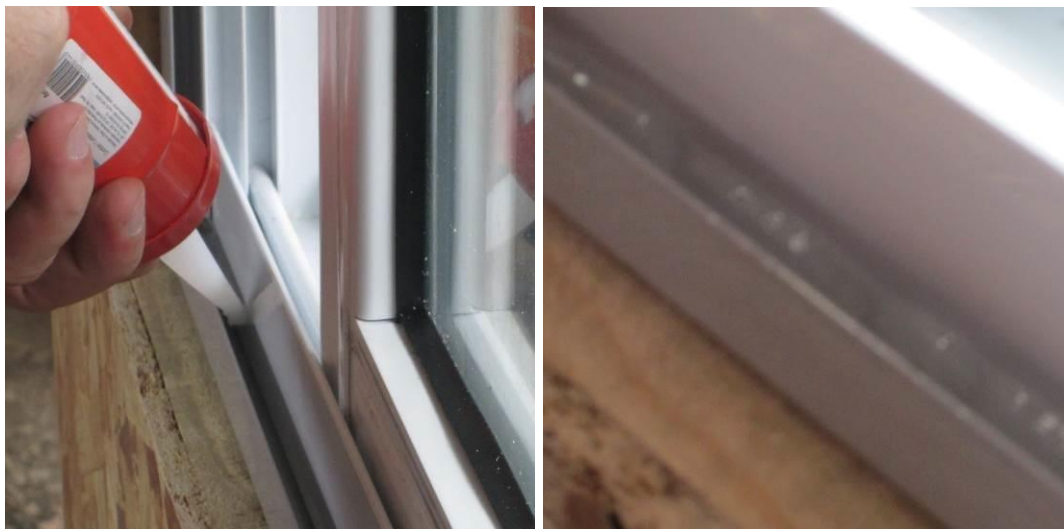
Figura 67 - Aplicação de vedante na aba interna do marco perimetral
