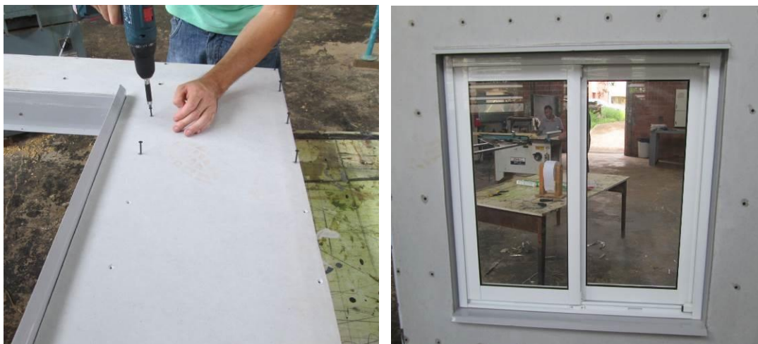
Figura 92 - Aplicação da placa cimentícia e instalação da esquadria de alumínio
