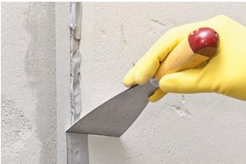
Figura 32 - Aplicação de selante de poliuretano na interface da parede
