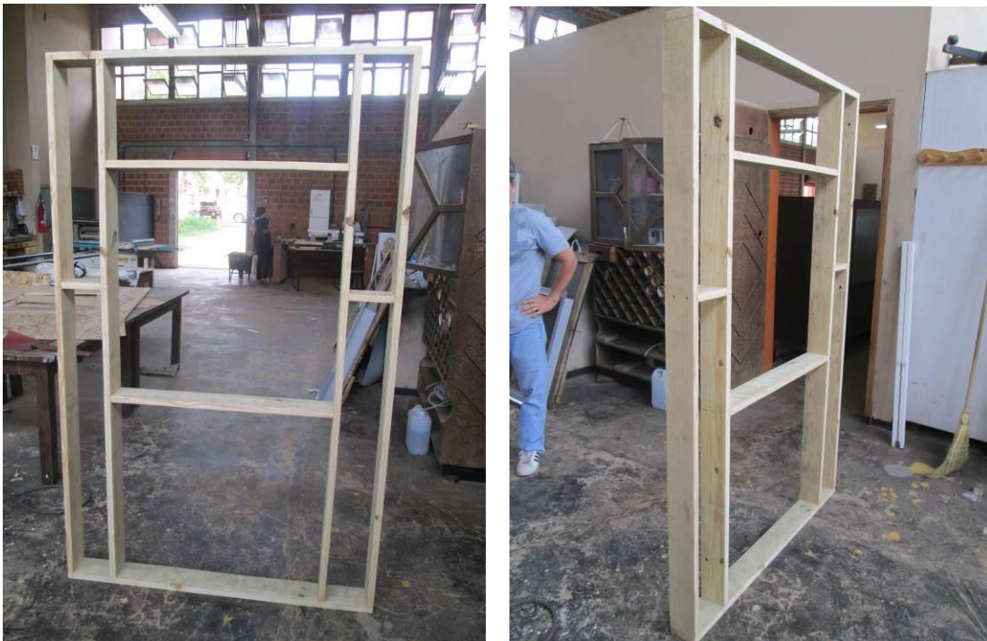
Figura 44 - Montagem total da estrutura
