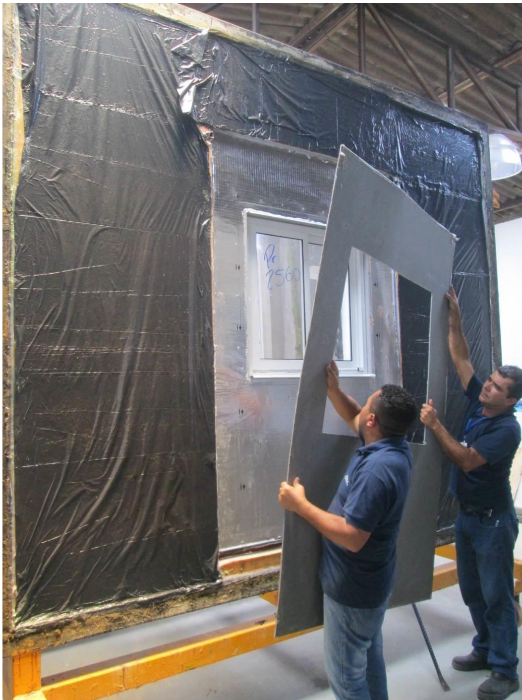
Figura 79 - Retirada da placa cimentícia
