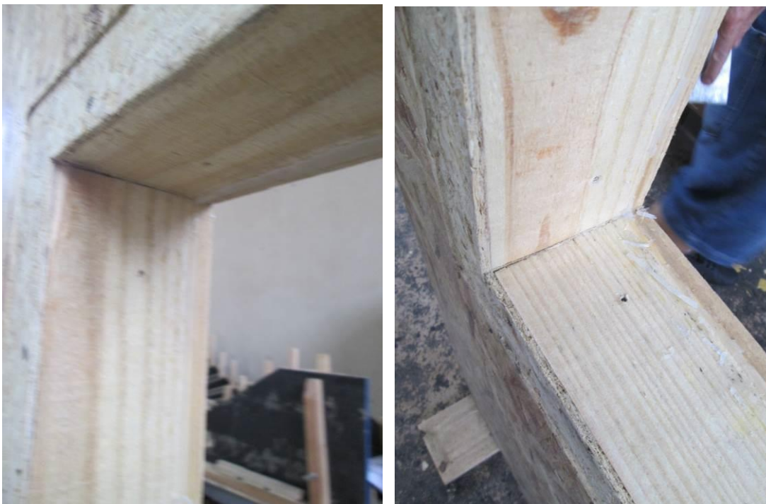
Figura 86 - Pannel com os componentes removidos
