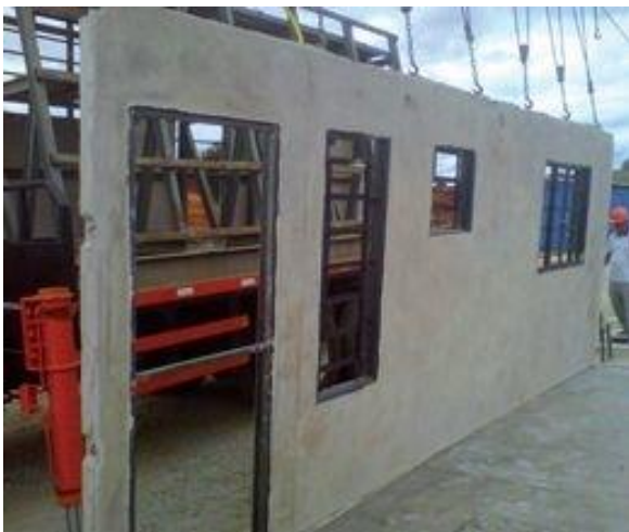
Figura 9 - Painel de concreto armado com caixilhos
