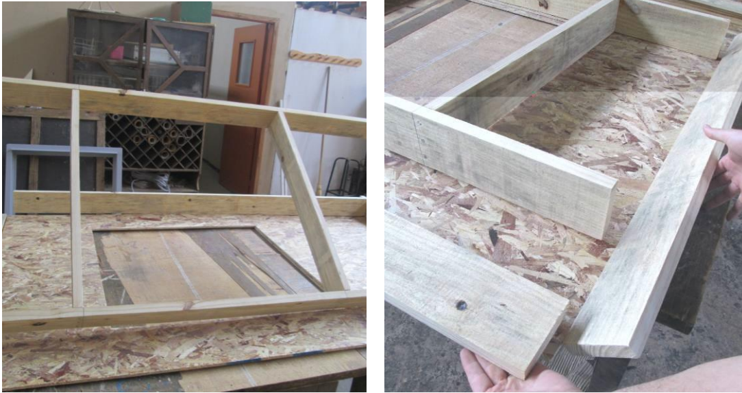
Figura 43 - Montagem parcial da estrutura
