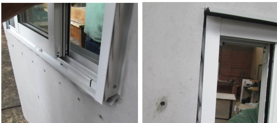
Figura 66 - Encaixe total da esquadria no vão
