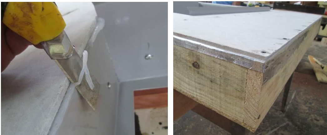
Figura 61 - Acabamento no painel
