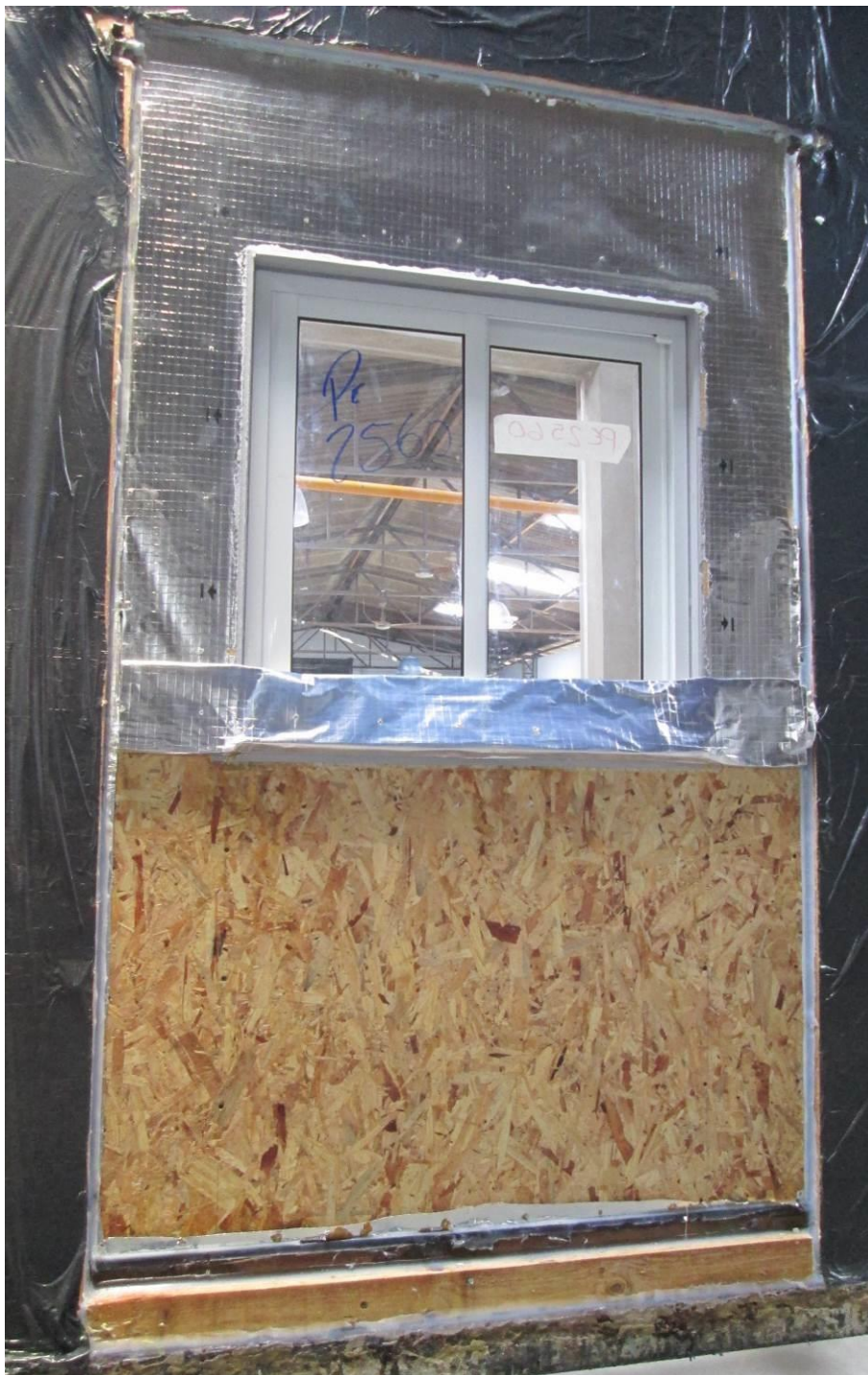
Figura 81 - Retirada parcial da membrana
