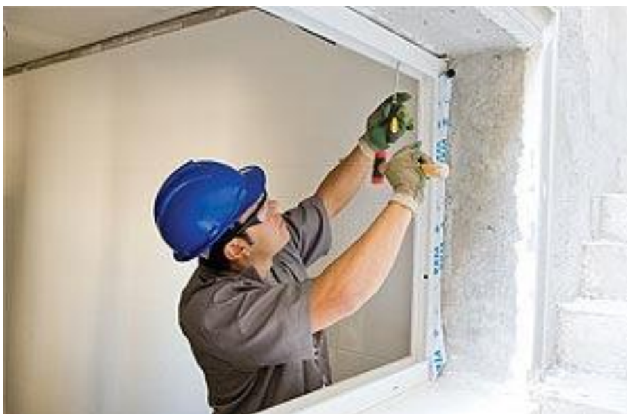
Figura 12 - Fixação esquadria de PVC
