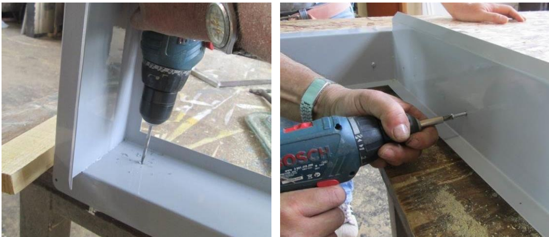
Figura 51 - Fixação do marco perimetral
