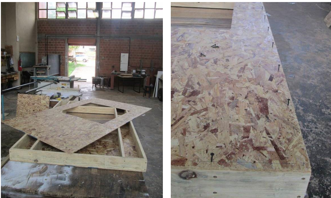
Figura 46 - Fixação das chapas de OSB
