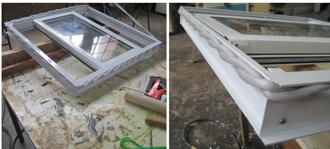
Figura 64 - Aplicação do tarucel na esquadria
