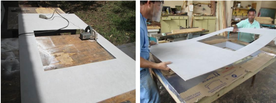
Figura 58 - Preparo da placa cimentícia
