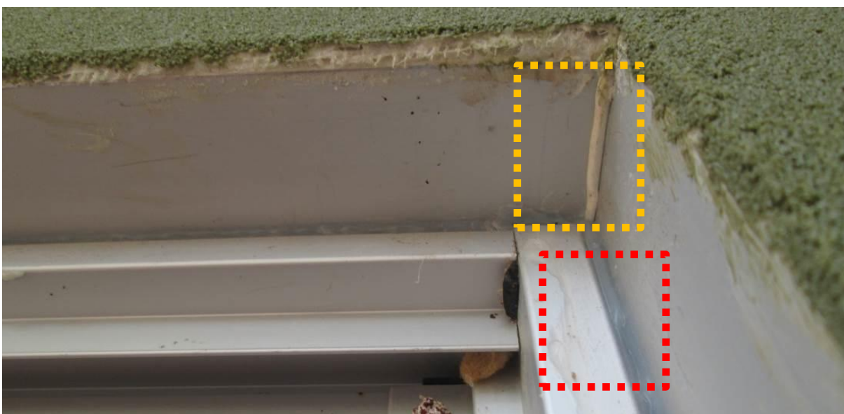
Figura 29 - uso de vedante de silicone em esquadrias
