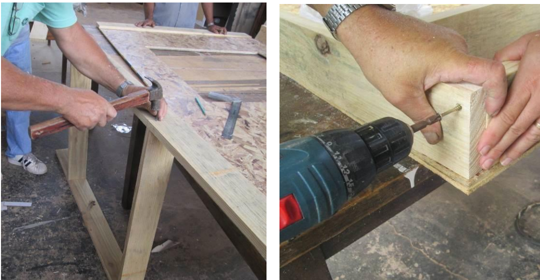
Figura 42 - Fixação das peças de madeira
