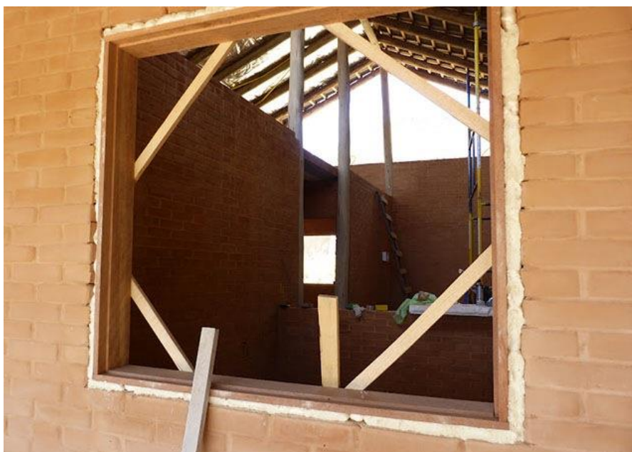
Figura 16 - Fixação do marco de madeira com espuma expansiva
