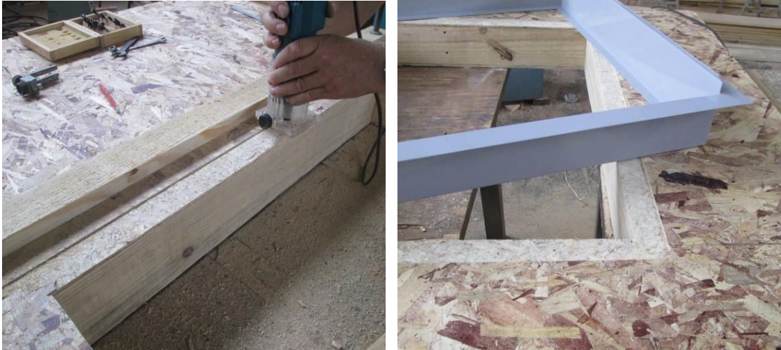
Figura 50 - Rebaixo sobre a chapa OSB
