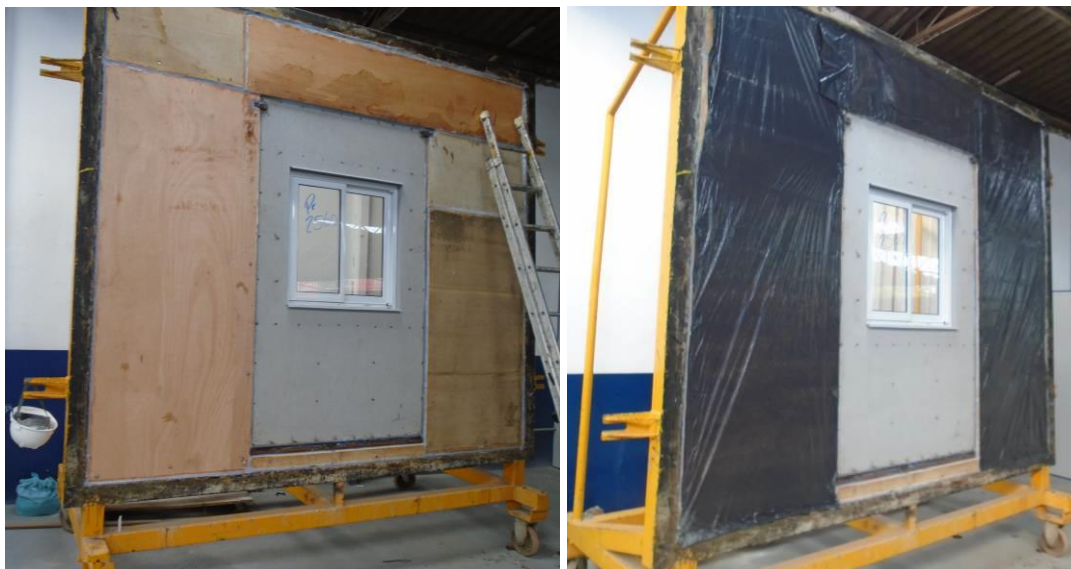
Figura 73 - Preparação do painel no pórtico
