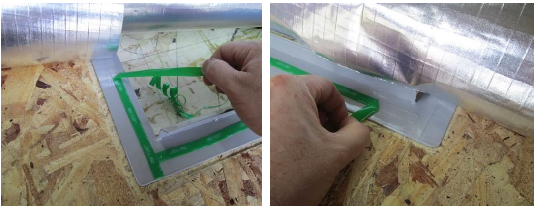
Figura 55 - Aplicação da membrana
