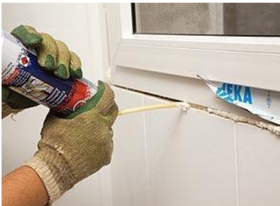
Figura 13 - Aplicação de espuma expansiva
