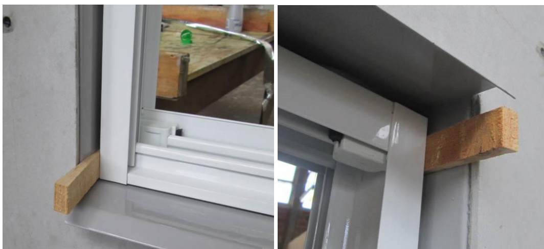
Figura 68- Posicionamento da esquadria dentro do vão
