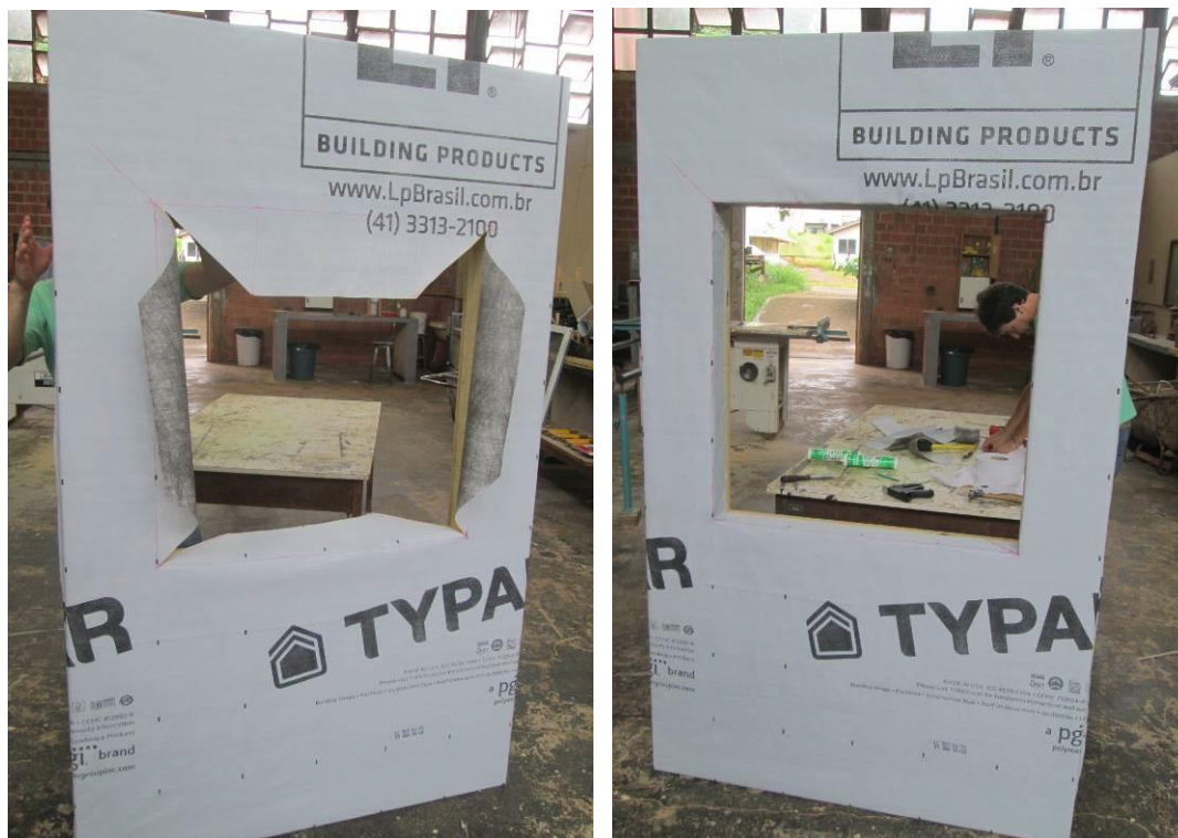
Figura 88 - Aplicação da membrana hidrófuga
