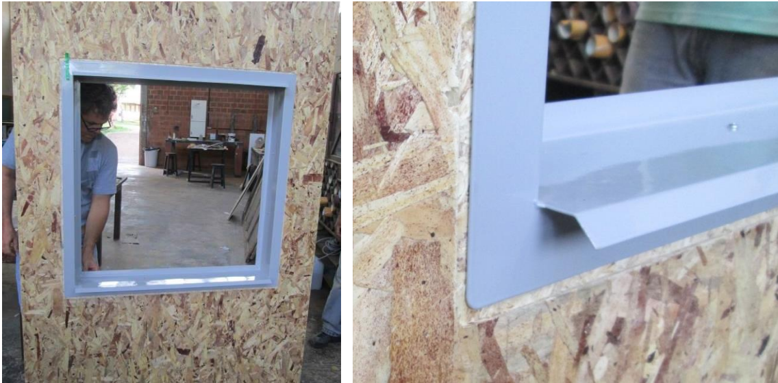
Figura 52 - Instalação do Marco perimetral
