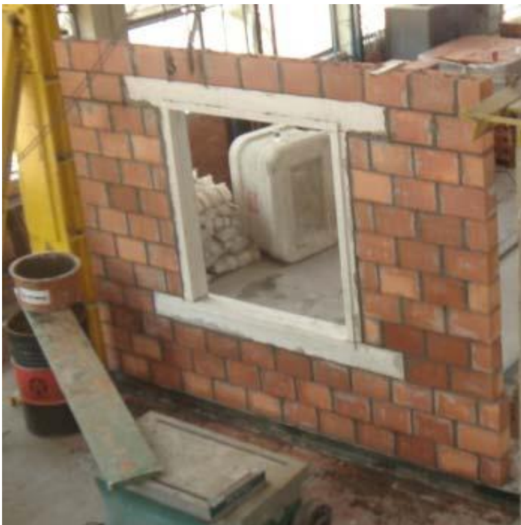
Figura 28 - Componente aplicado em parede de bloco cerâmico
