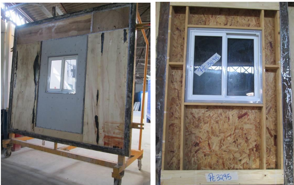
Figura 94 - Painel instalado no pórtico da câmara de teste
