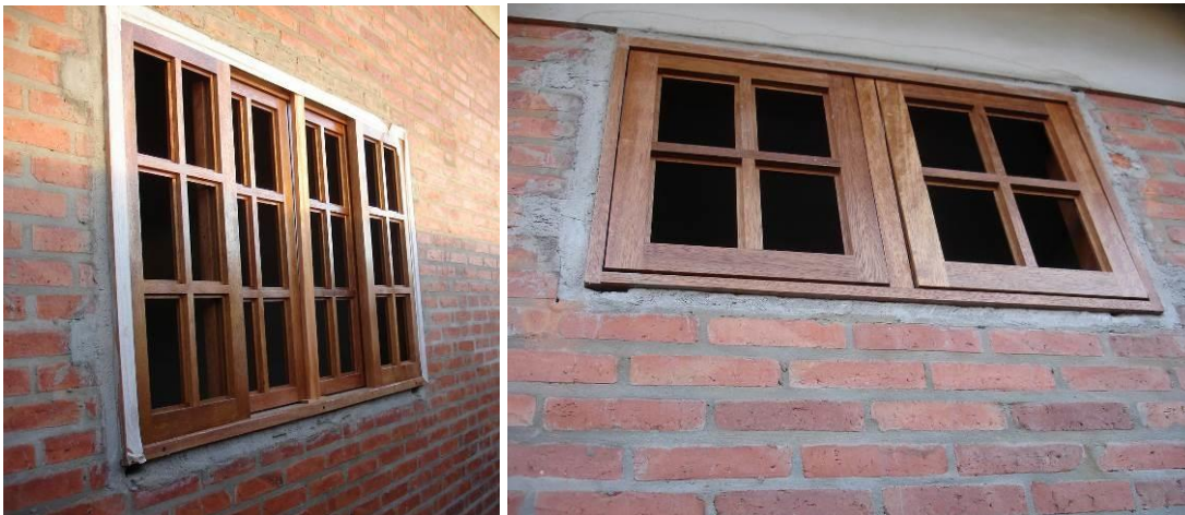
Figura 15 - Instalação de esquadrias de madeira em alvenarias
