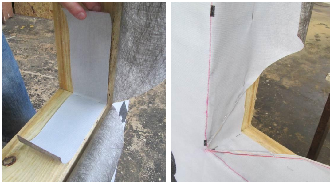
Figura 89 - Detalhes de aplicação da membrana
