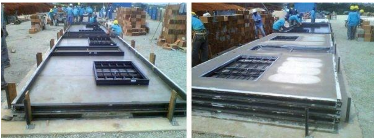
Figura 10 - Esquadria posicionada dentro do painel
