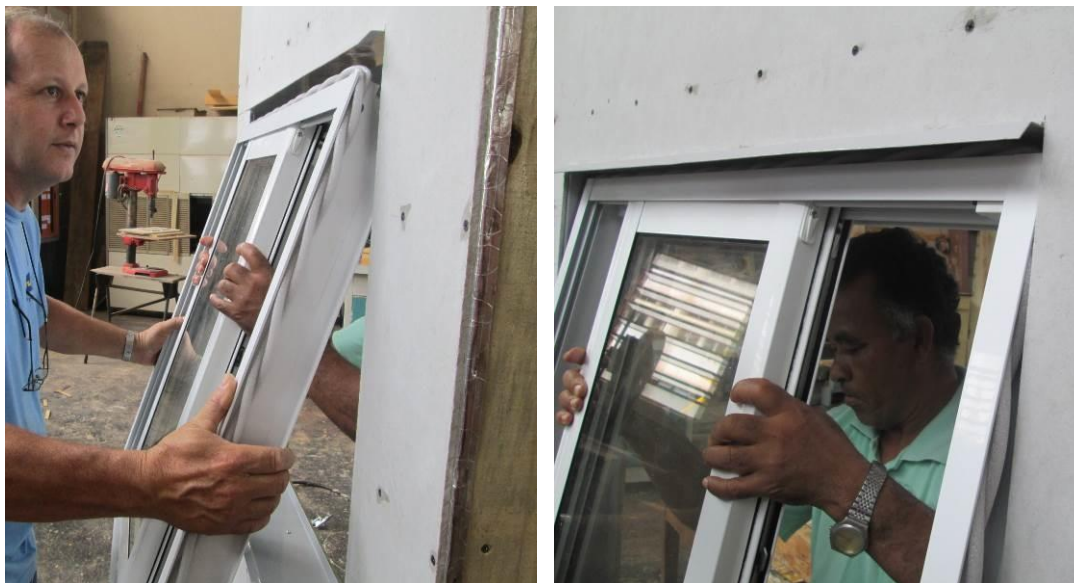
Figura 65 - Instalação da esquadria
