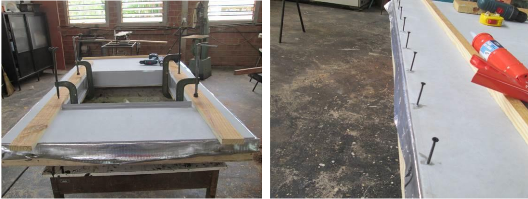
Figura 60 - Fixação da placa cimentícia
