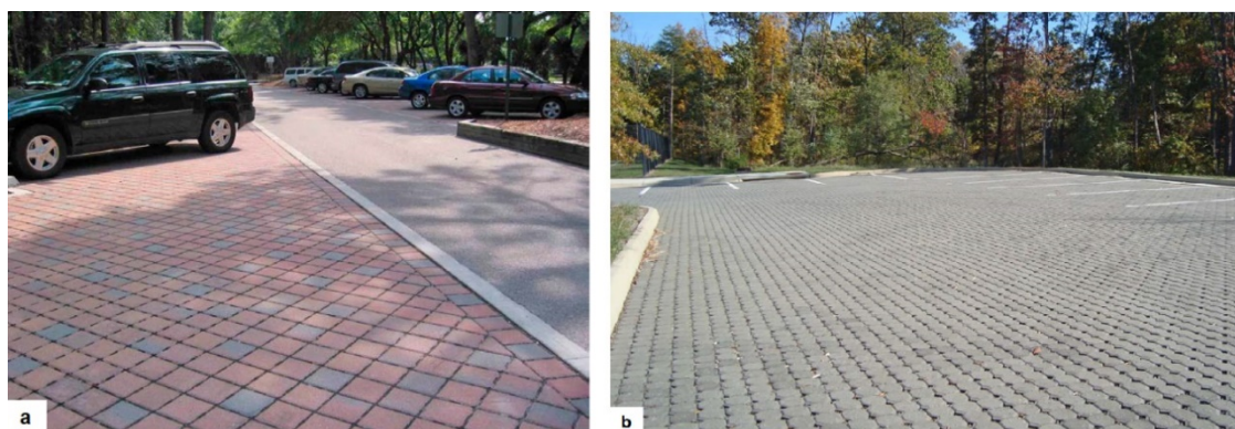
Figura 4 – Exemplos de pavimentos intertravados de concreto permeável. Em (a) estacionamento composto por blocos de concreto permeável e (b) estacionamento composto por blocos de concreto cuja percolação ocorre pelas juntas entre os blocos
