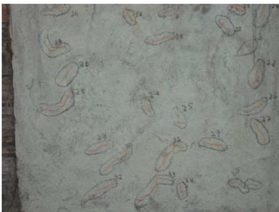
Figura 42 – Revestimento com a argamassa AB1
