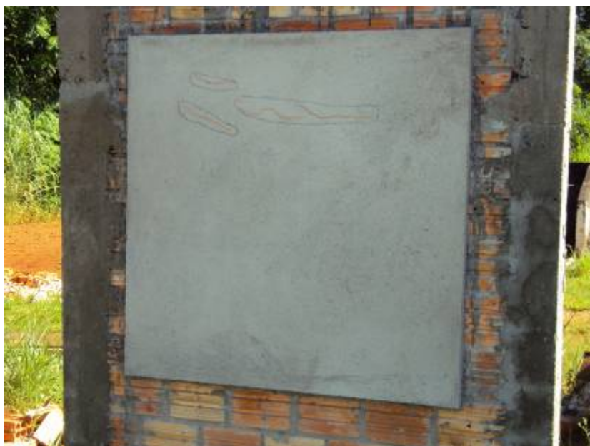
Figura 43 – Revestimento com a argamassa AB2
