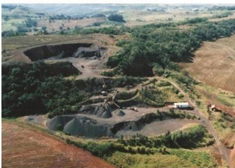
Figura 31 – Vista aérea da pedreira Guaravera
