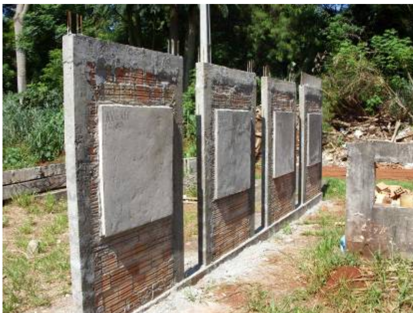
Figura 40 – Face norte das paredes para o ensaio de fissuração
