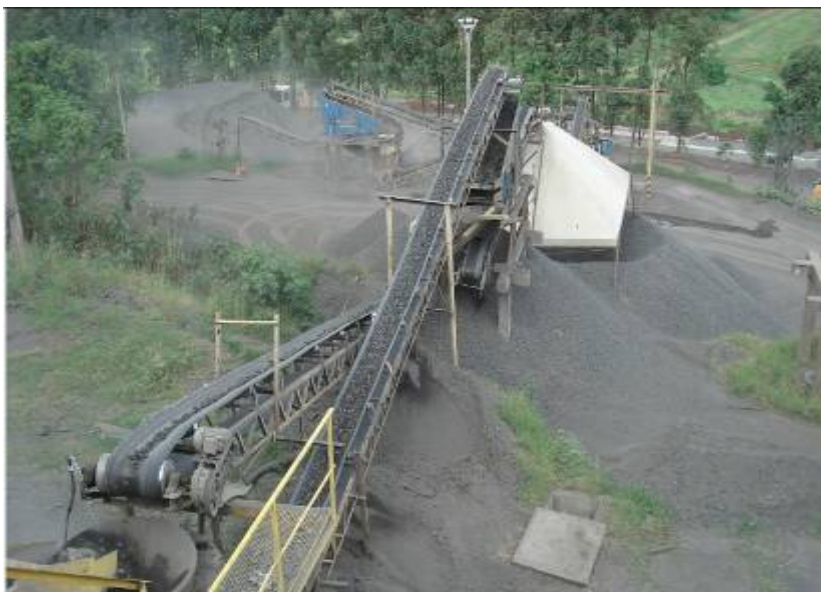
Figura 30 – Usina de britagem em operação – pedreira Guaravera
