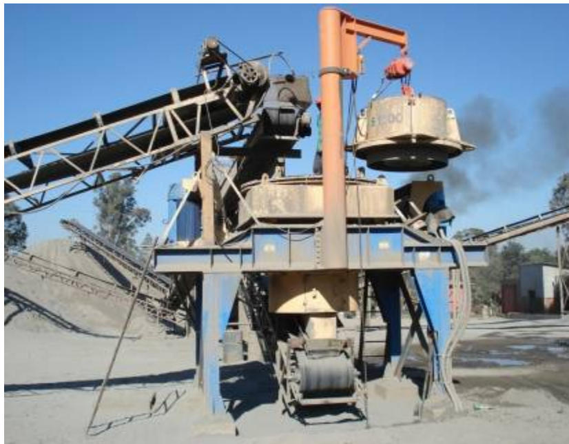
Figura 29 – Britador V. S. I. desmontado para manutenção
