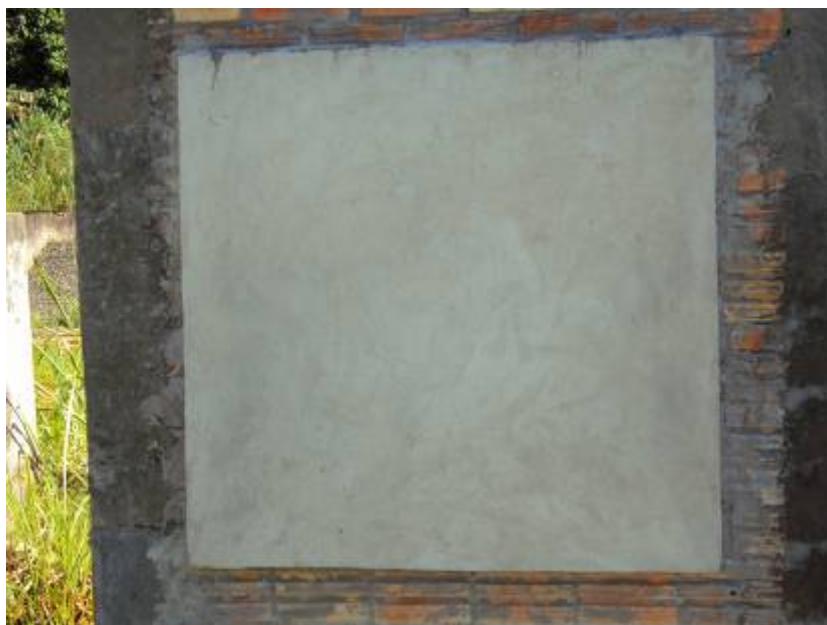
Figura 41 – Revestimento com a argamassa de referência
