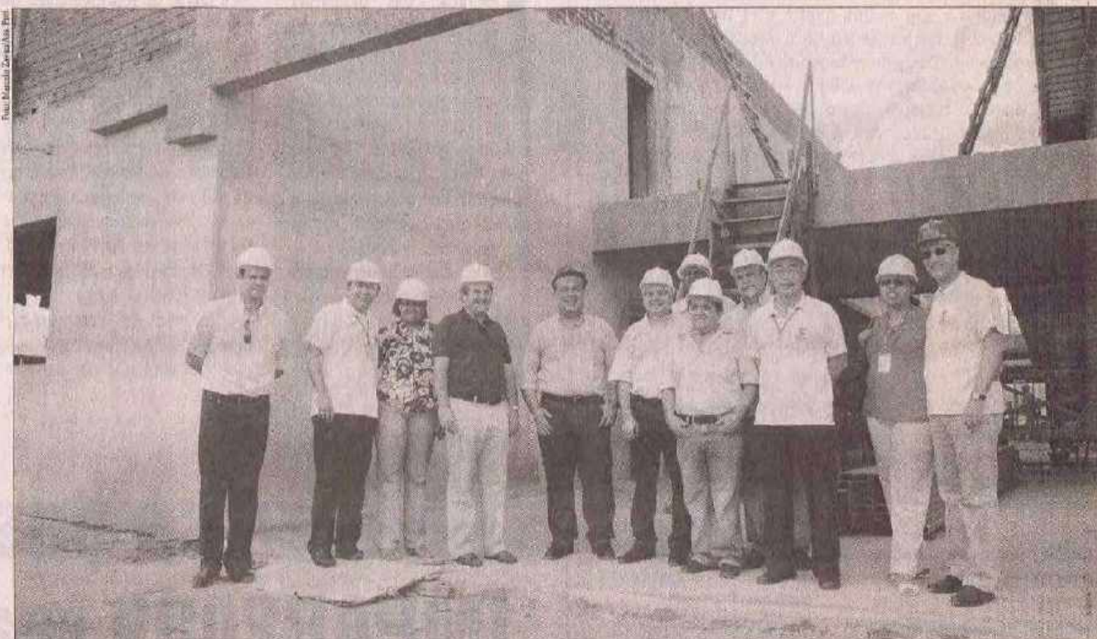
A comitiva também visitou a obra do campus de Paranavaí do Instituto Federal
