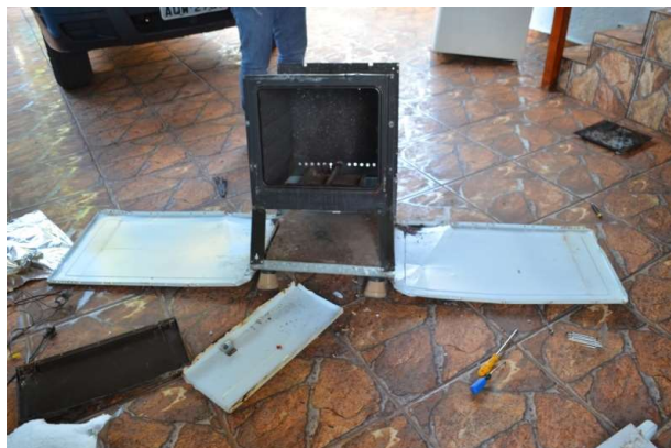
Figura 11 – Retirada das Paredes Externas e das Paredes do Forno do Fogão Desmontado
