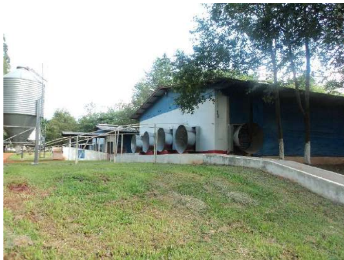
Figura 55- Vista externa de um pavilhão de gestação climatizado. Sistema de resfriamento do ar e túnel de ventilação forçada.
