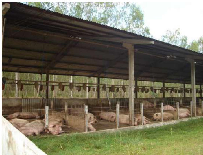
Figura 53- Pavilhão de gestação não climatizado. Modelo construtivo simples e sem equipamentos de climatização.
