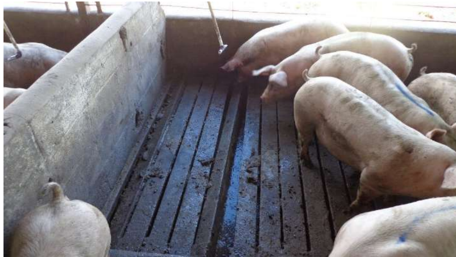
Figura 15- Baia de suínos de produção. Os pisos quebrados colocam em risco o bem-estar dos animais.
