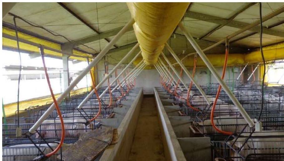
Figura 58- Granja com salas de maternidades climatizadas. Utilizando telha isotérmica, sistema de ventilação com ar resfriado direcionado para fêmeas.
