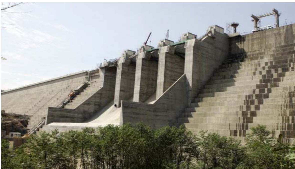
Figura 4 – Vista da barragem da UHE de Mauá em novembro de 2011
