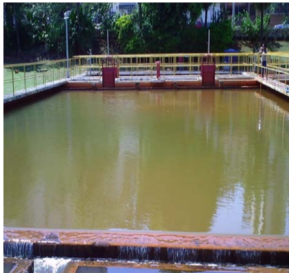
Figura 7 - Decantador ETA-Cafezal
