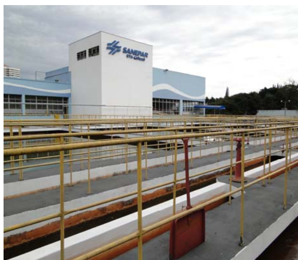
Figura 5 - Vista geral da ETA-Cafezal
