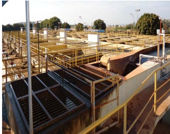
Figura 1 - Vista geral da ETA-Tibagi
