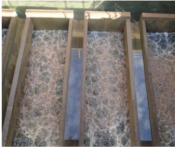
Figura 11 – Lavagem do filtro ETA-Tibagi
