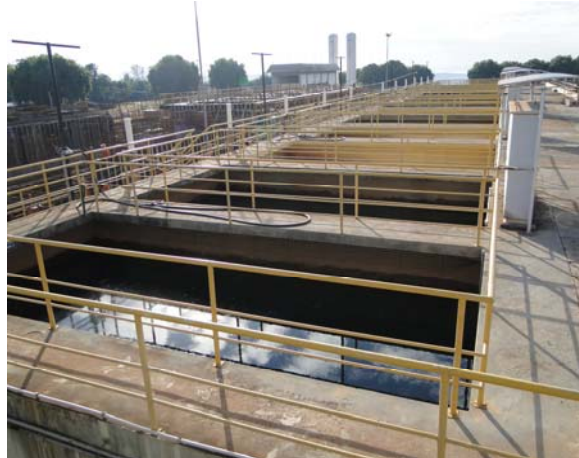
Figura 4 - Filtros da ETA-Tibagi
