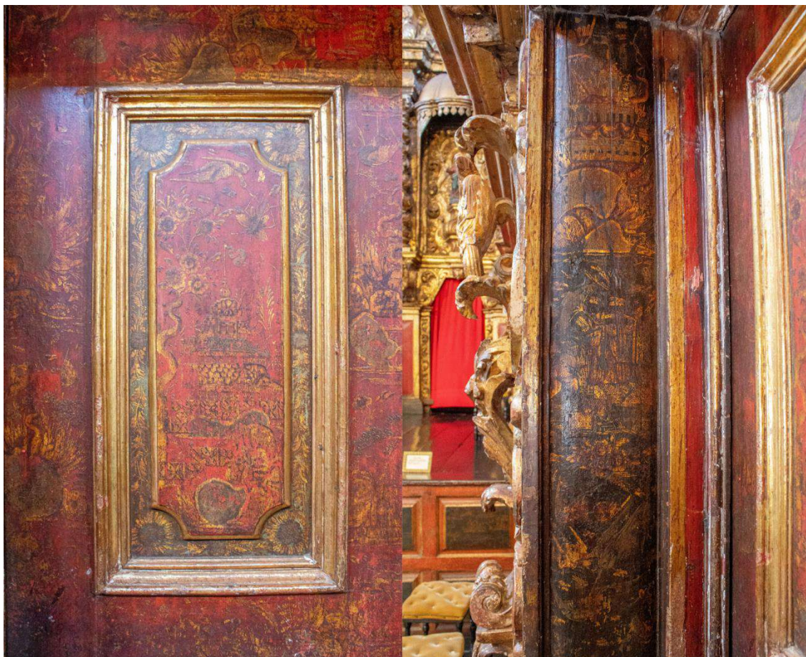
Figura 7 – Detalhes do batente e da porta da sacristia da Igreja Matriz de Nossa Senhora da Conceição, Sabará (MG). Fonte: Acervo pessoal. Foto: Lucas Pinto Rezende, Sabará/MG.
