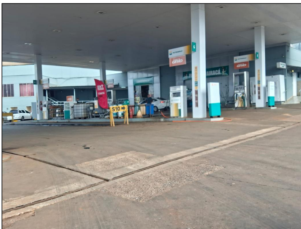
Figura 30 - Posto de Combustível onde se localiza o poço P133, município de Cambará - PR.
