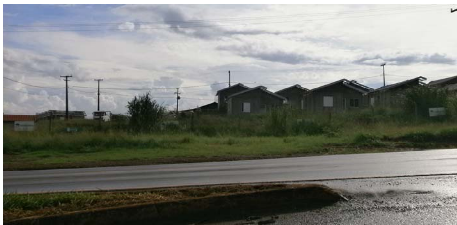
Foto 20 - Foto da entrada do Village Alto da Warta.
