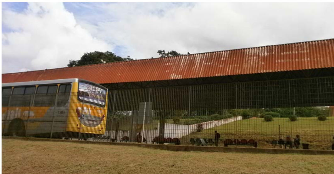
Foto 9 - Terminal de ônibus do Distrito de Irerê
