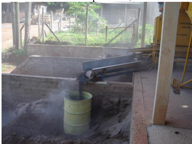
Figura 31 – Rebritagem do material retido na peneira 4,8 mm
