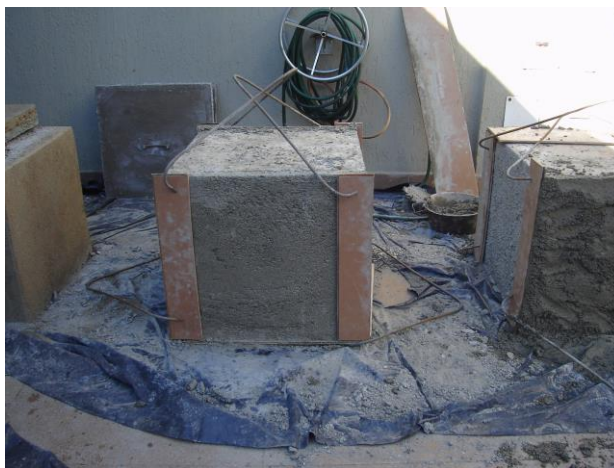
Figura 54– Execução do revestimento de argamassa REF-A, ARN, ARB e ARA nos protótipos
