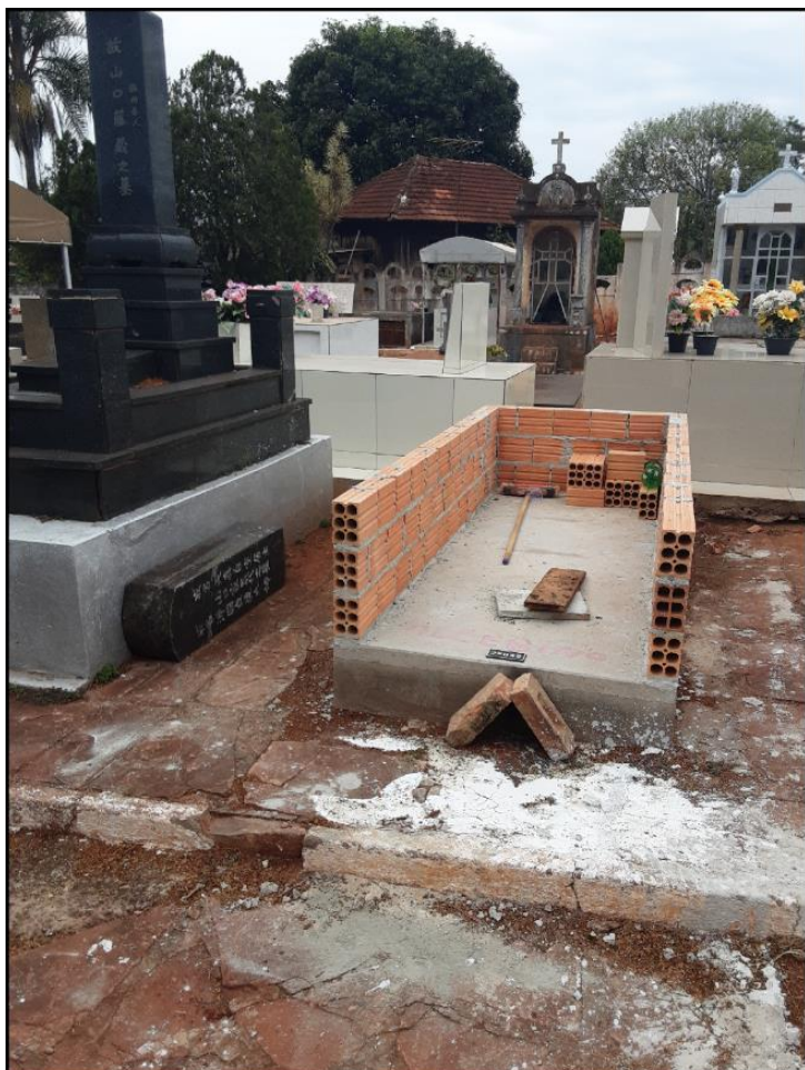
Figura 14 – Novo sepultamento com túmulo em construção em 2020
