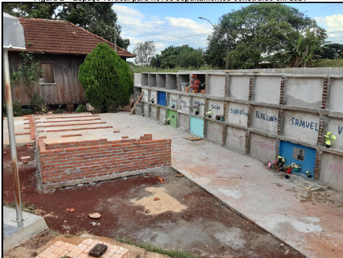
Figura 2 – Espaço vertical para novos sepultamentos construído em 2021
