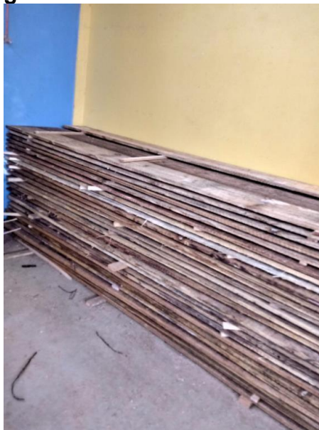
Figura 29 - Armazenamento do lote
