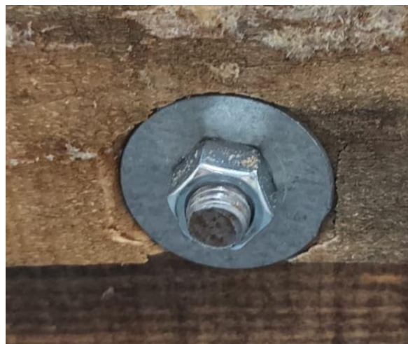
Figura 49 - Esmagamento lâmina
