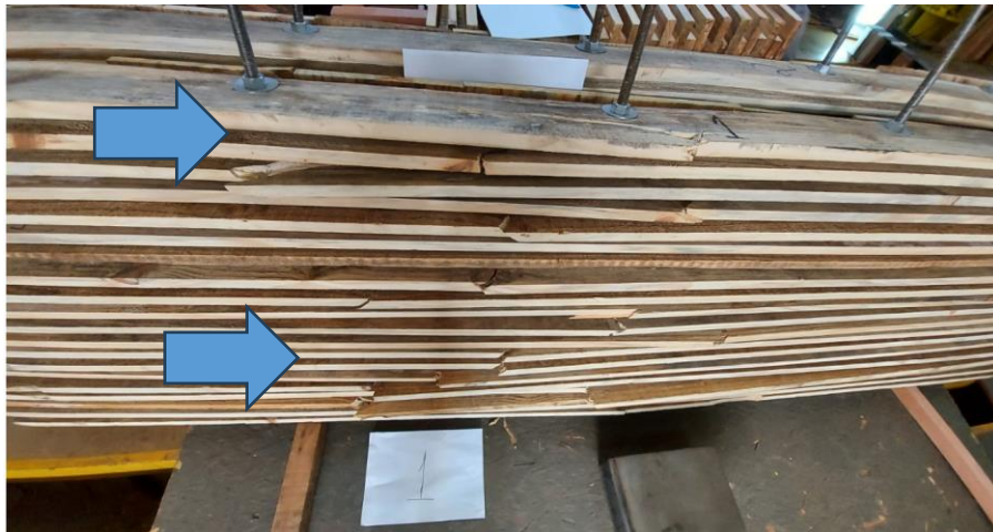
Figura 58 - Rupturas lâminas CP1
