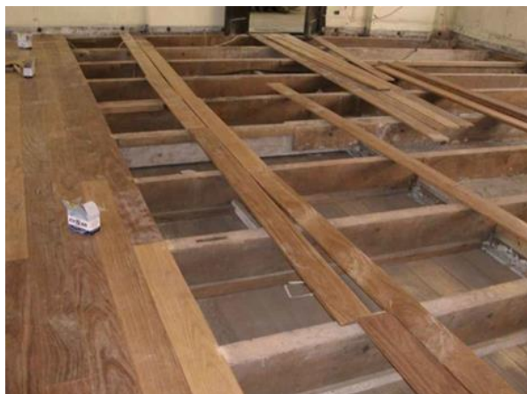
Figura 1 - Elementos de um assoalho de madeira tradicional
