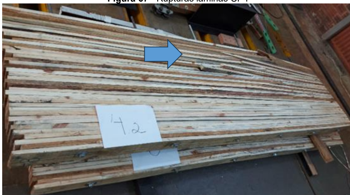
Figura 67 - Rupturas lâminas CP4
