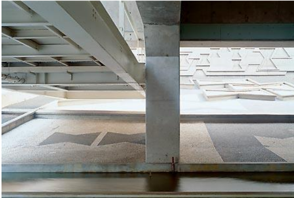
Figura 36 – Vista para o auditório, espelho d'água e passarela metálica fixada nos pilares existentes
