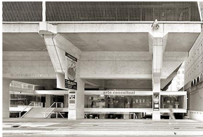
Figura 44 – Leveza do volume em relação ao edifício
