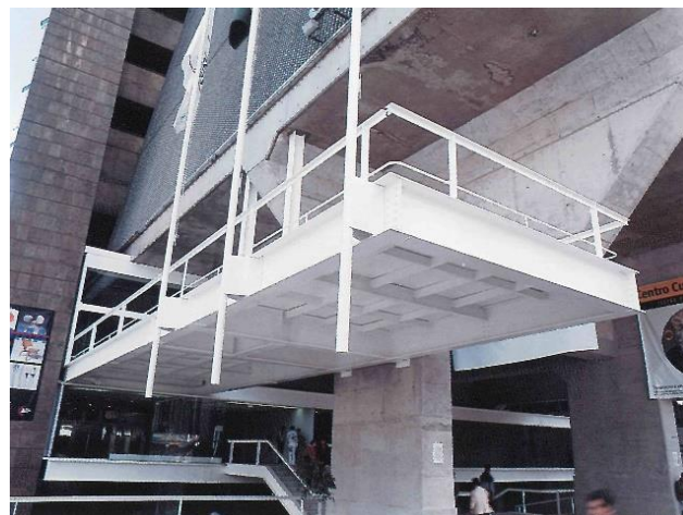
Figura 37 – Ponte metálica avançando sobre o passeio da Avenida Paulista
