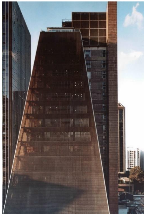
Figura 9 – Brises e corpo piramidal da fachada
