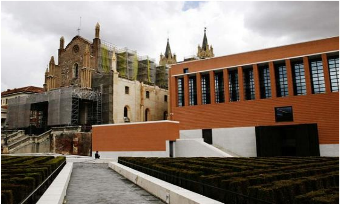
Figura 20 – Ampliação do Museu do Prado. Arquiteto: Rafael Moneo, Madri, Espanha (1996-2001).
