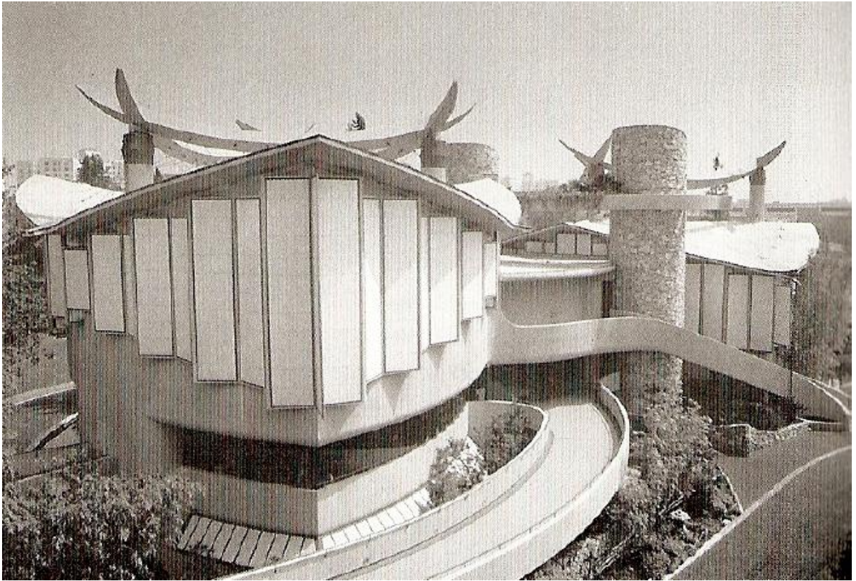
Figura 18 – Pavilhão de Arte Japonesa no LACMA. Arquiteto: Bruce Goff, Los Angeles, (1982-1989).
