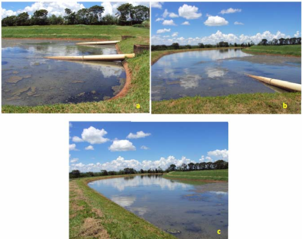
Figura 2 – Lagoas de estabilização da Estação de Tratamento de Esgoto do Serviço Autônomo de Água e Esgoto (SAAE), Bandeirantes-PR (a-c).
