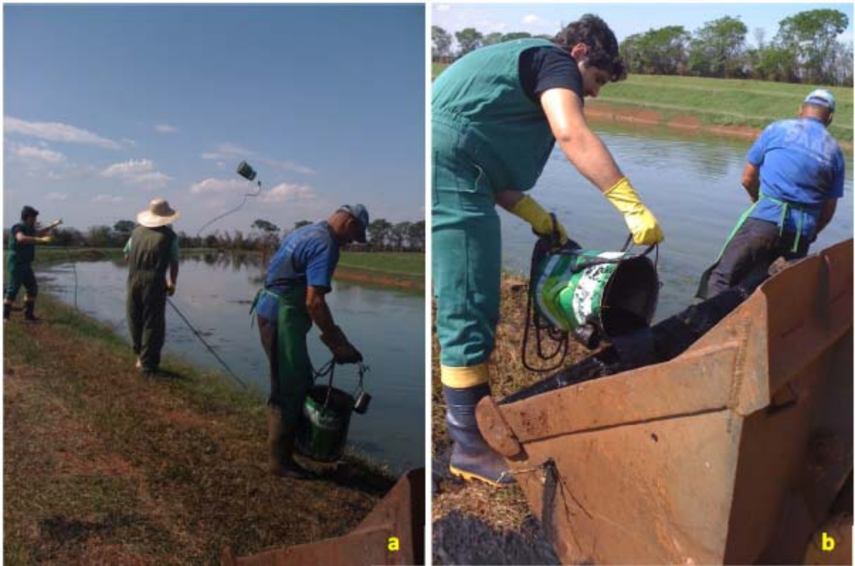
Figura 3 – Coleta do lodo de esgoto na lagoa de estabilização da Estação de Tratamento de Esgoto do Serviço Autônomo de Água e Esgoto (SAAE), Bandeirantes-PR (a-b).
