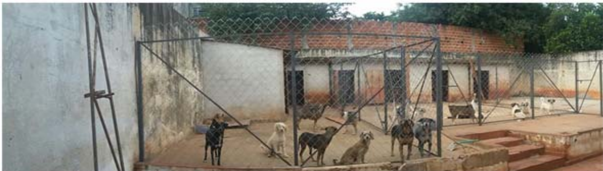
Figura 9 - Reconstrução do local onde permanecia parte dos cães e dos gatos, adequação dos canis com pavimentação de toda área de terra e separação dos animais com grades
