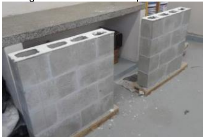
Figura 32 – Detalhe da Mini parede 1 e 2
