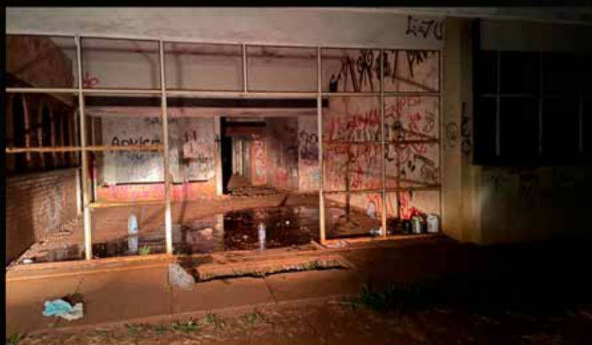
Figura 47 - Hospital abandonado de Cambé-PR
