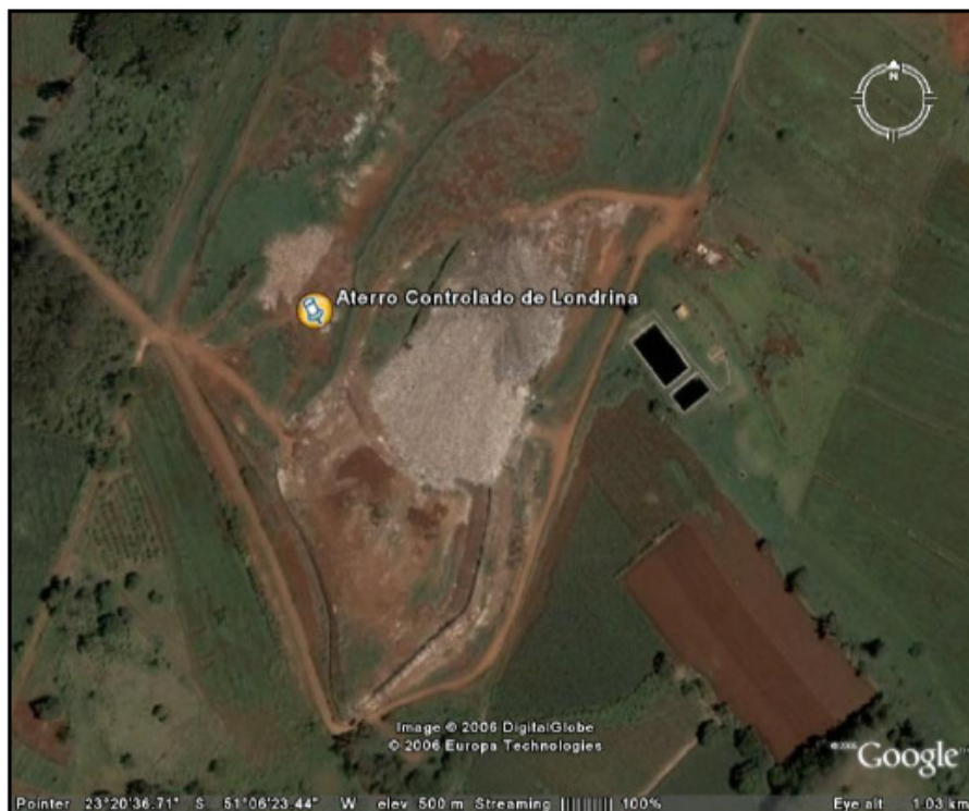
Figura 4.1: Vista Aérea do Aterro Controlado de Resíduos Sólidos Urbanos de Londrina (PR)
