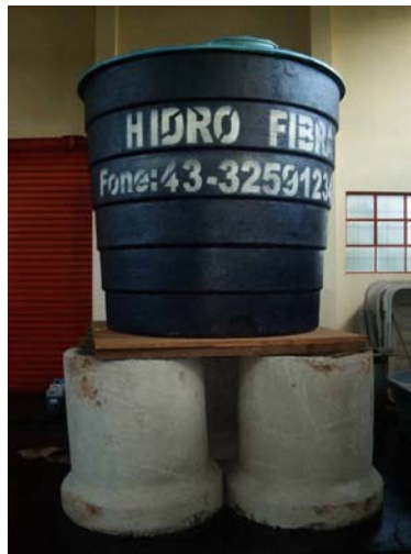
Figura 4.2: Reservatório de 5000 litros para armazenamento do lixiviado bruto
