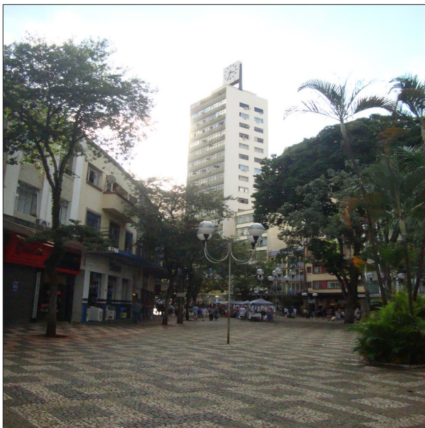
Edifício América (ao fundo) – Londrina (PR)
