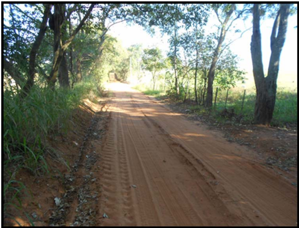
b) A mesma estrada, sem preparação para o controle de erosões
