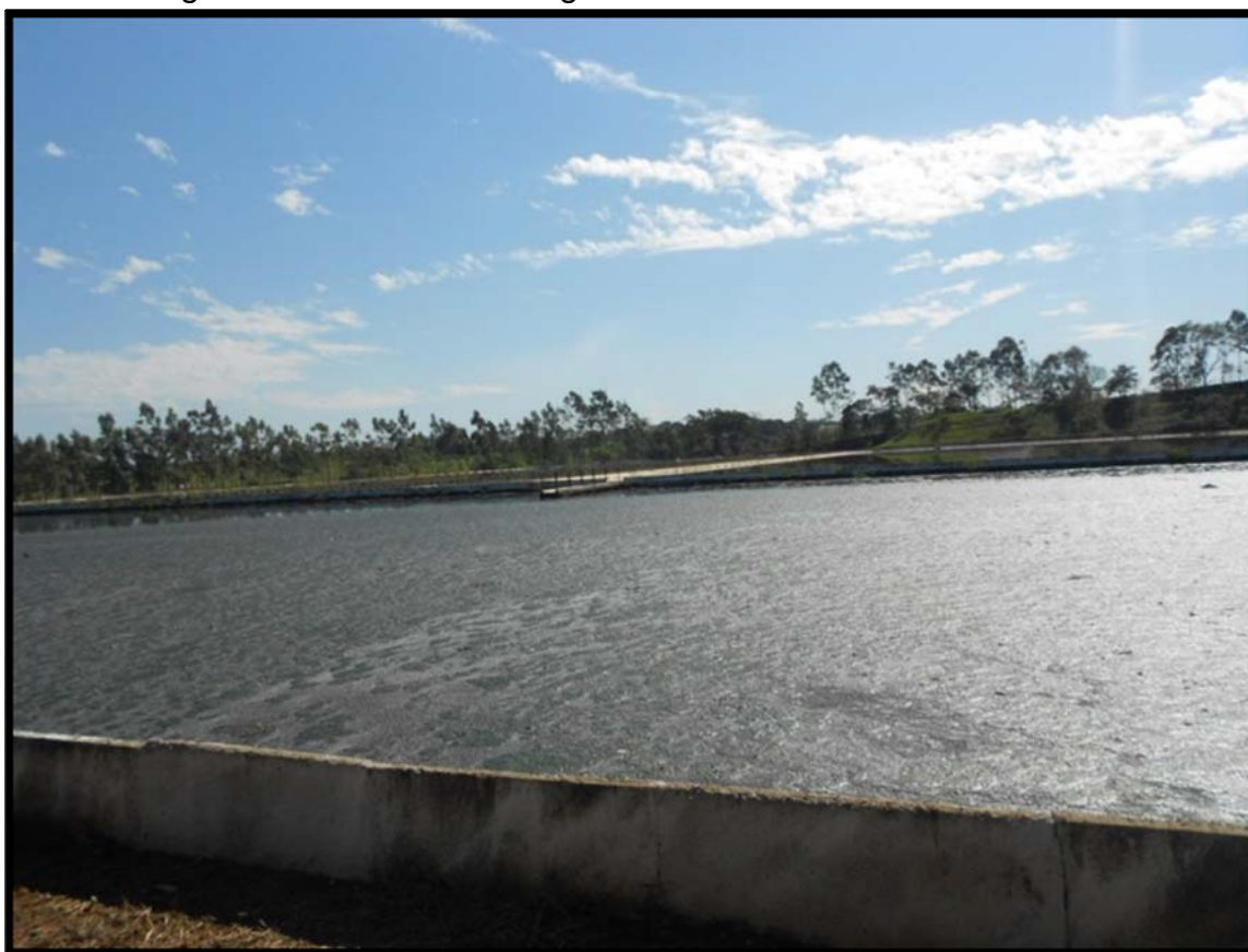
Foto 9 – Lagoa de tratamento de esgoto de Santa Fé do Sul
