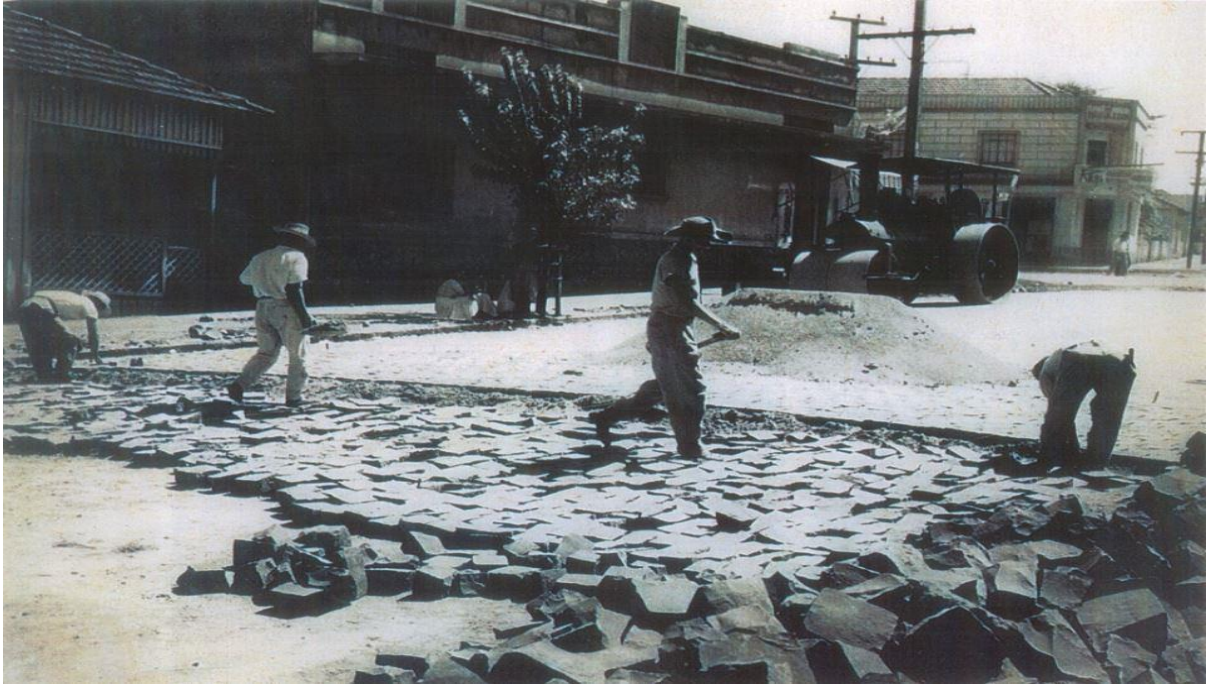
Figura 22: Calçamento da Rua Mario de Menezes com paralelepípedos (1958)
