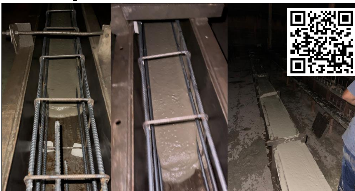
Figura 66 – Pré-moldado de concreto no estado fresco
