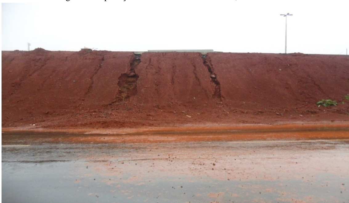
Figura 40 - Ponto 9 – Aterros e processos de ravinamentos com escoamento para a rede drenagem na duplicação Rodovia Celso Garcia Cid, Cambé-PR.
