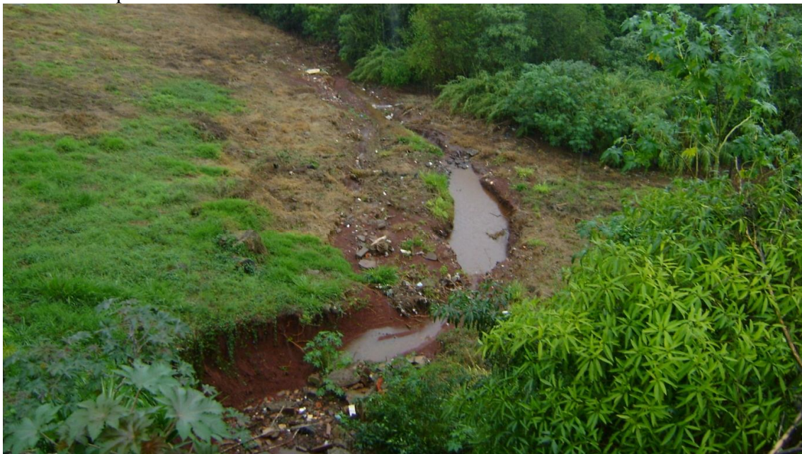
Figura 32 - Ponto 5.2 - Fluxo de escoamento pluvial concentrado direcionado pela BR369 e despejado na cabeceira aterrada em Área de Preservação Permanente, carreado para mata ciliar.
