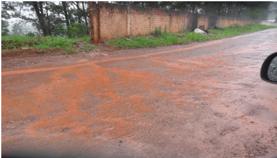
Figura 39 - Ponto 8 – escoamento pluvial em parte da rua Francisco Alves sem pavimentação asfáltica.
