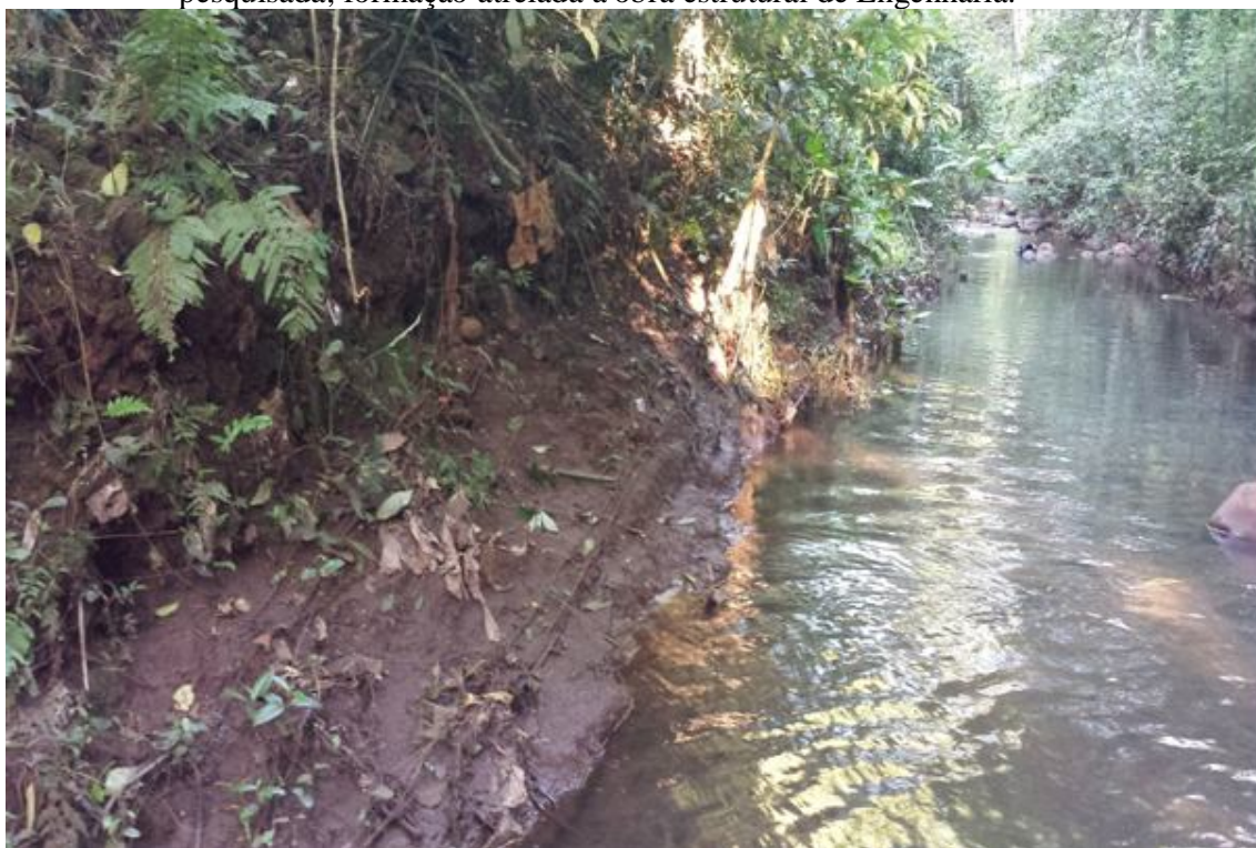
Figura 20 - Dique Marginal e solapamento da margem direita, próximo a jusante da área pesquisada; formação atrelada a obra estrutural de Engenharia.
