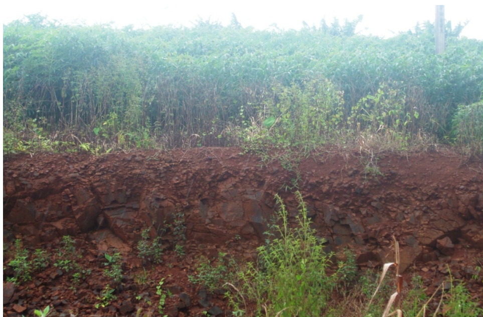
Figura 16 – Corte de estrada na fazenda Akolá.
