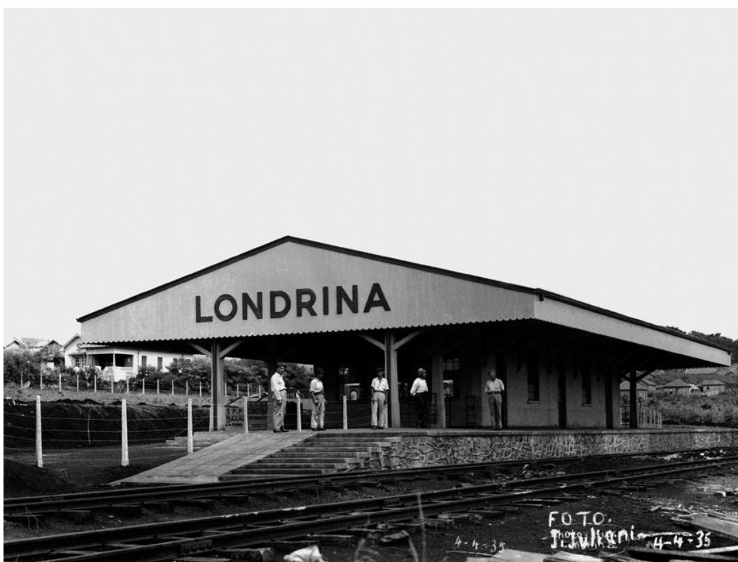
Figura 2 – Primeira Estação Ferroviária de Londrina, PR – 1935
