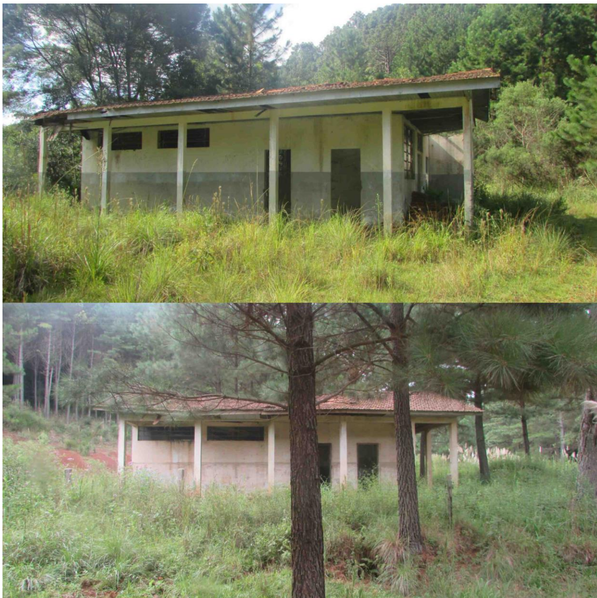
Figura 7 – Escolas abandonadas em General Carneiro
