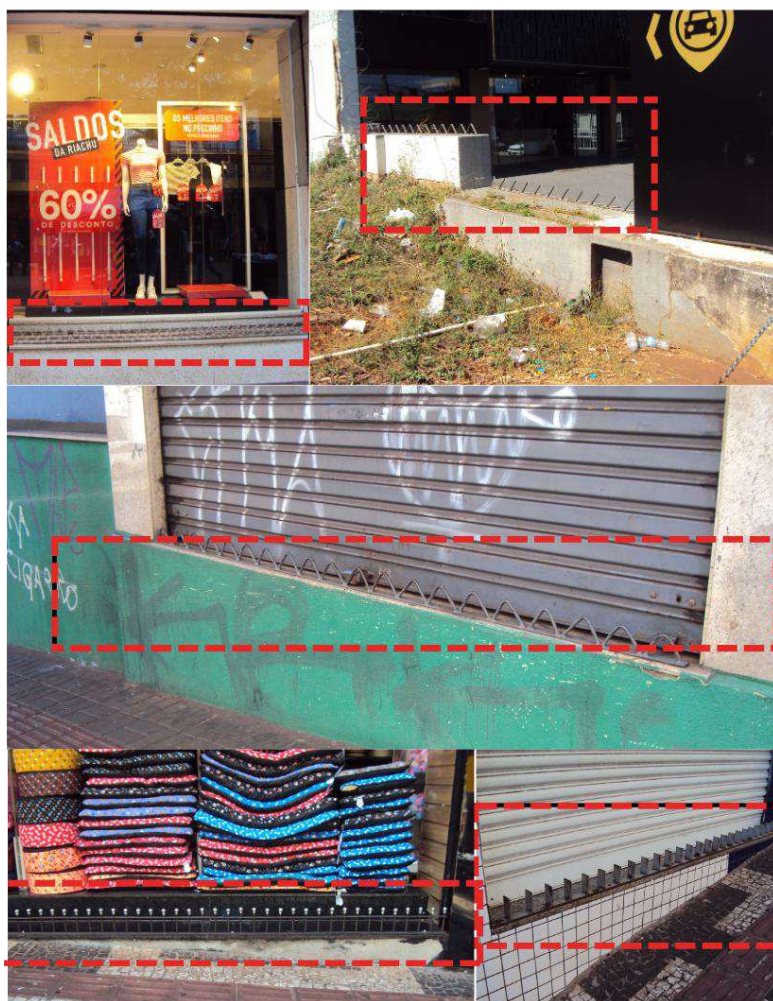
Figura 14 Elementos metálicos em locais associados ao uso comercial.
